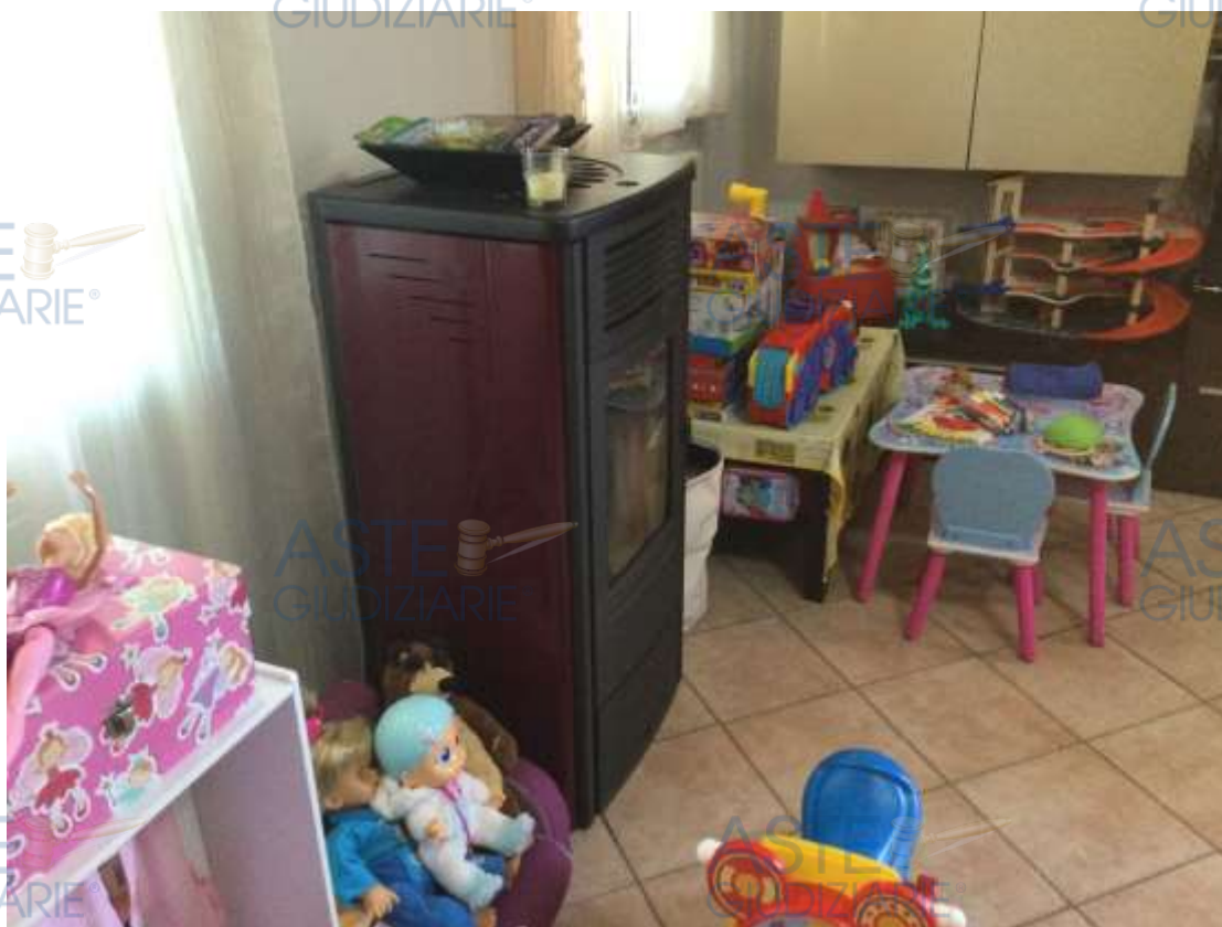
Vista del soggiorno con la stufa a pellets
