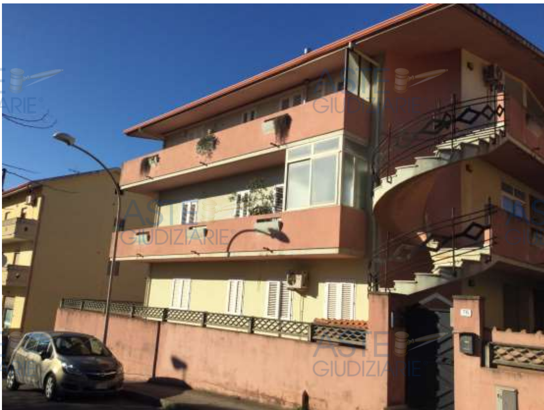
Vista del fabbricato dalla strada
