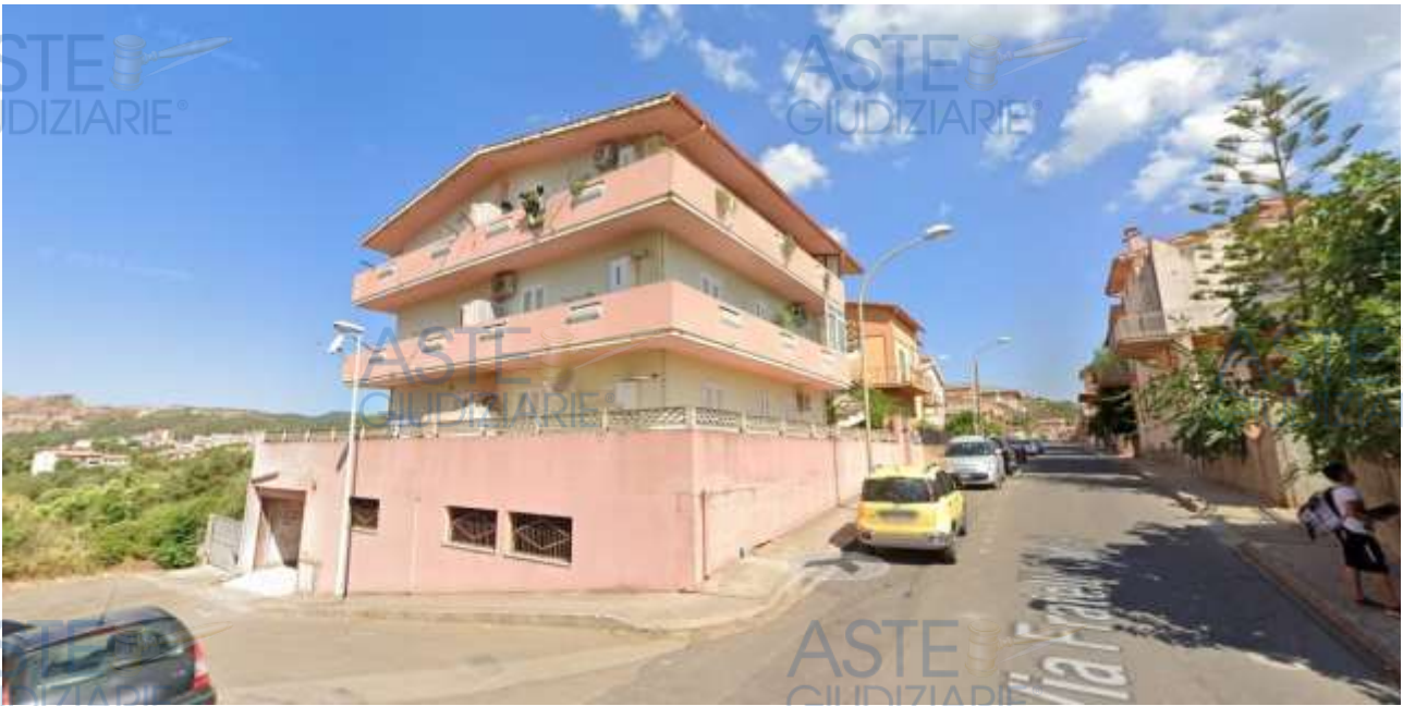
Vista del fabbricato dalla strada estratta da Google Maps
