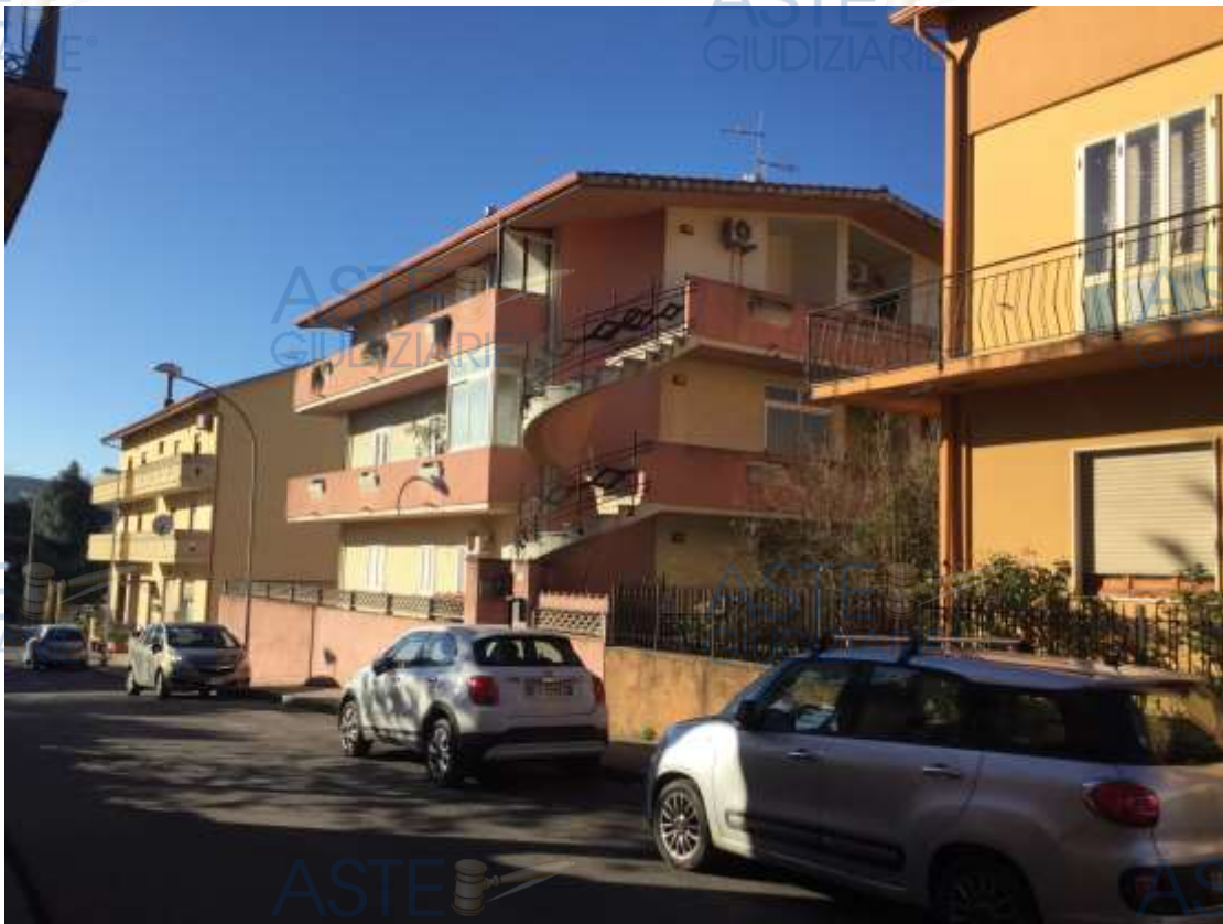
Vista del fabbricato dalla strada
