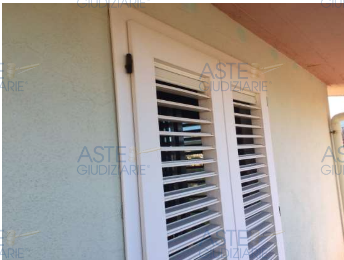
Vista dell'infisso dall'esterno
