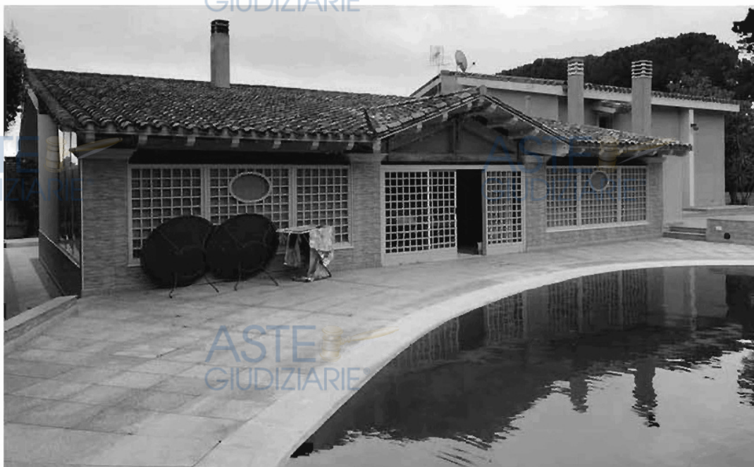
Foto 041 - Prospetto posteriore - Dettaglio fabbricato
