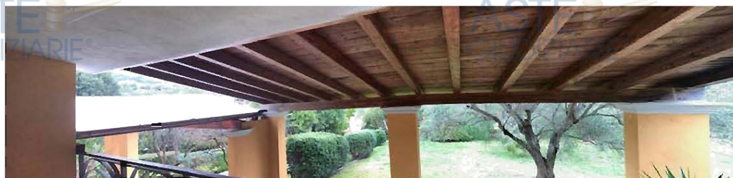
Foto 031 – Balcone coperto – Vista frontale
