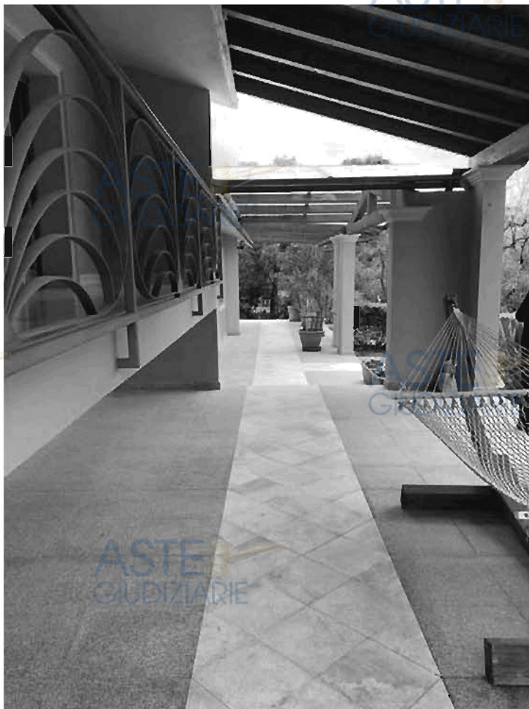
Foto 029 - Pergolato prospetto frontale – Coperture opaca e trasparente
