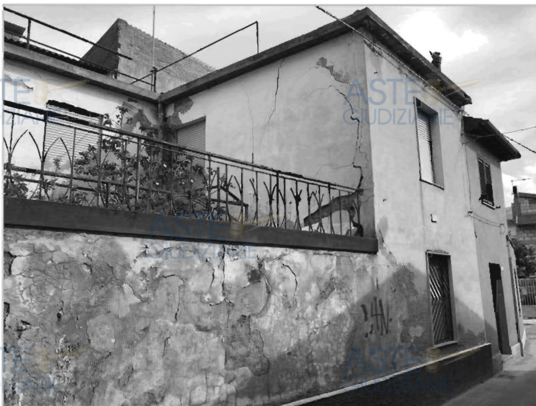
Foto 010 – Prospetto via Cadorna - Vista 2
