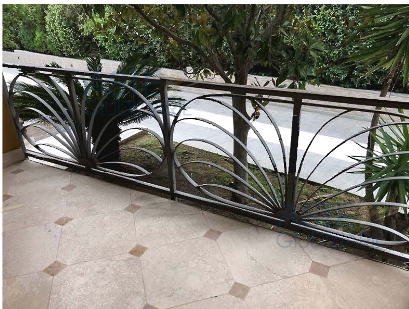
Foto 085 – Parapetto balcone camera padronale
