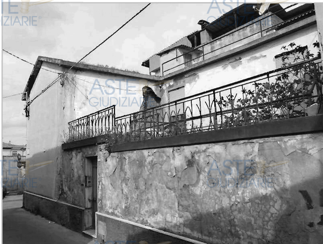
Foto 009 – Prospetto via Cadorna - Vista 1
