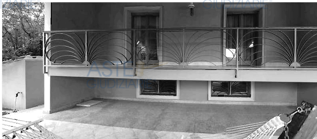
Foto 030 - Pergolato prospetto frontale – Balcone coperto
