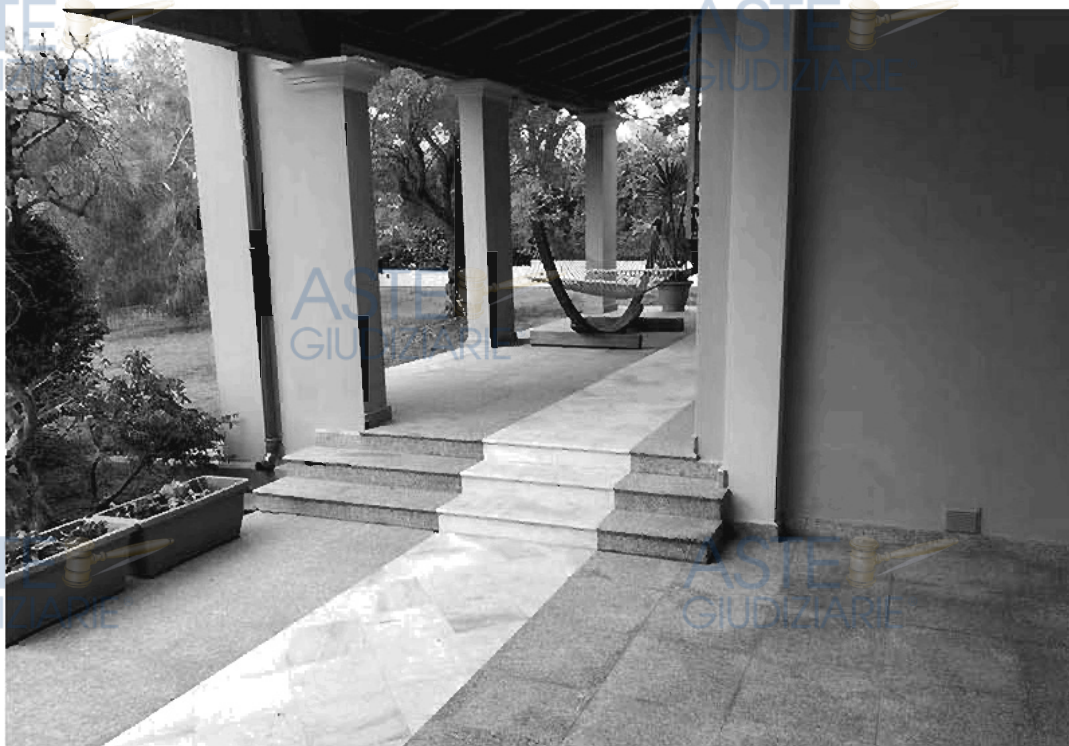
Foto 028 - Atrio ingresso – Copertura opaca pergolato
