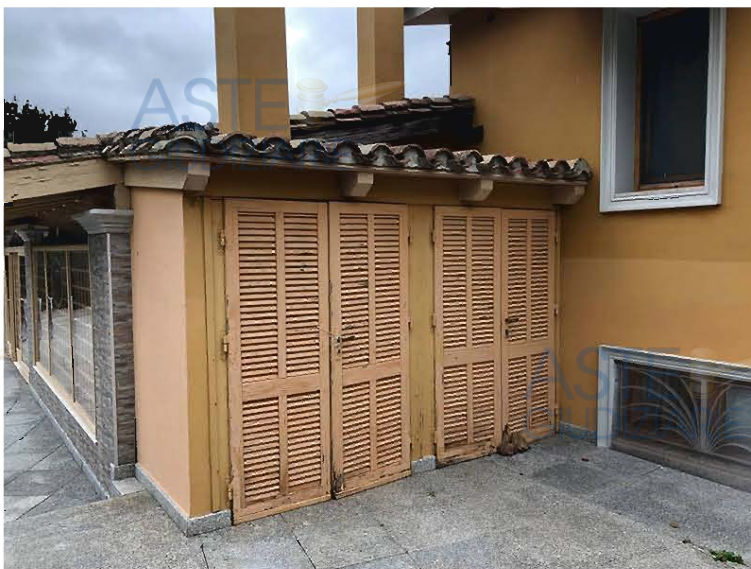
Foto 039 - Prospetto posteriore - Ripostiglio esterno
