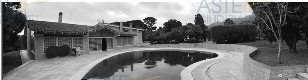
Foto 040 - Prospetto posteriore - Panoramica generale
