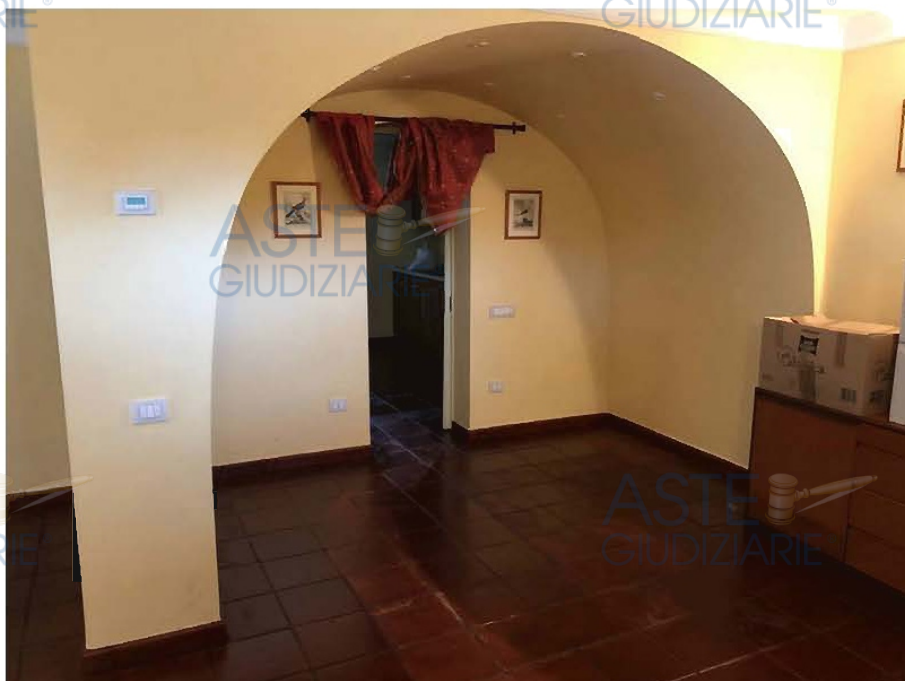
Foto 053 - Taverna piano seminterrato
