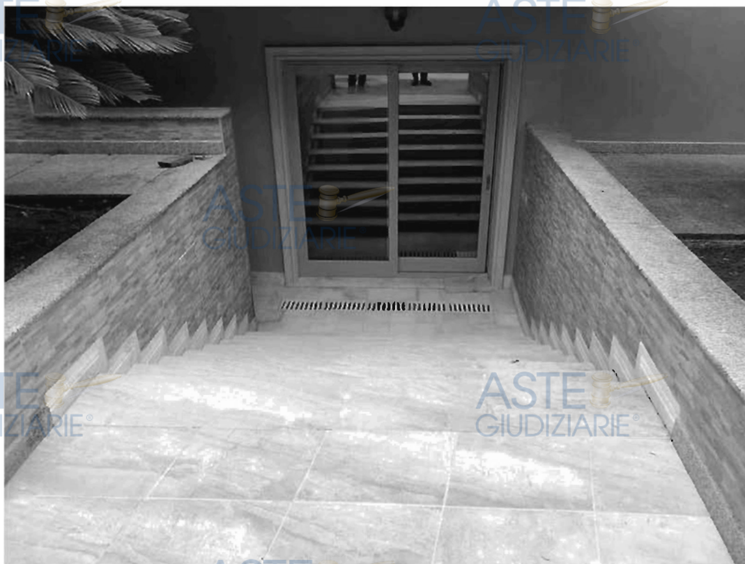
Foto 049 – Gradinata accesso al piano seminterrato
