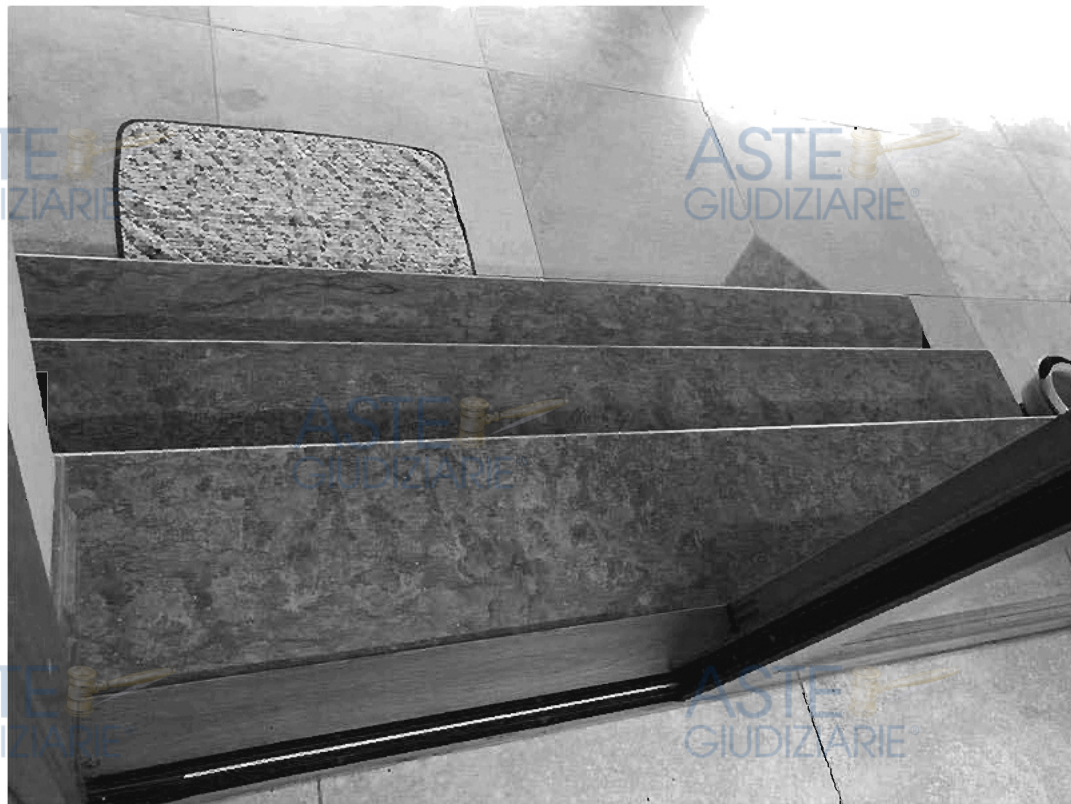
Foto 048 - Veranda posteriore - Dettaglio gradini cucina
