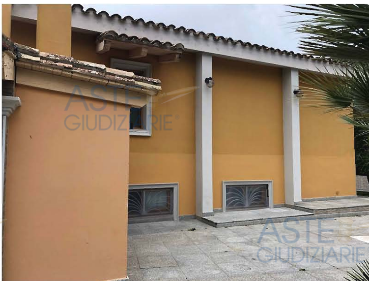
Foto 038 - Prospetto posteriore - Ripostiglio esterno
