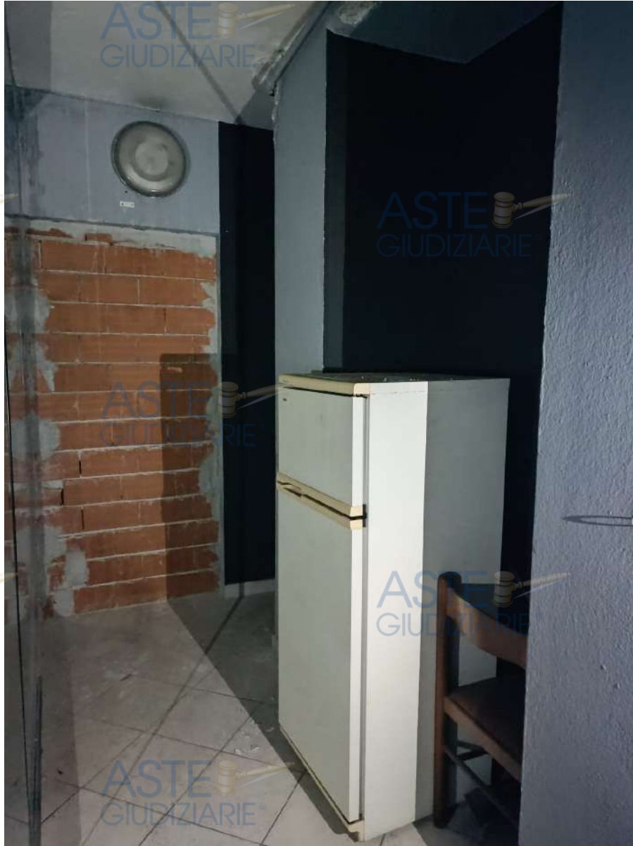
Foto 5: Porzione della palestra (sub 65) allo stato attuale inglobata nel sub 66
