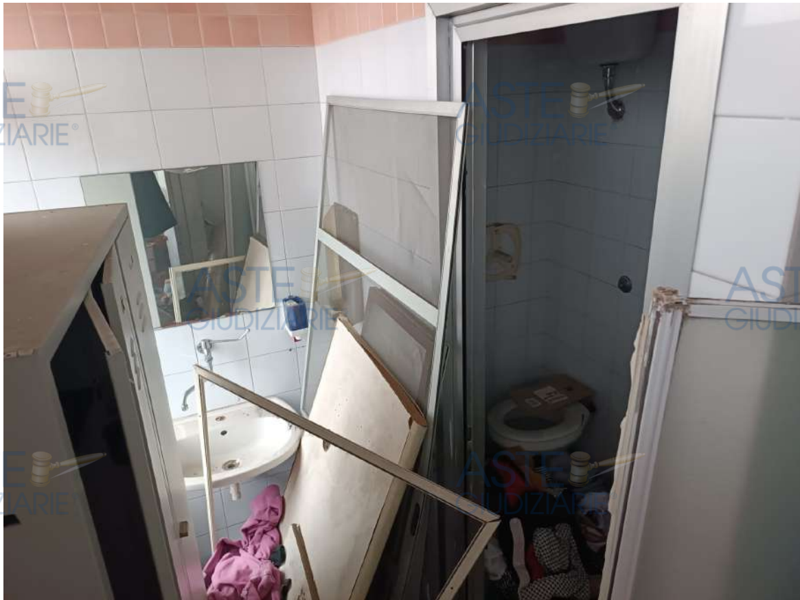
Foto 7: Particolare del bagno e dell'antibagno
