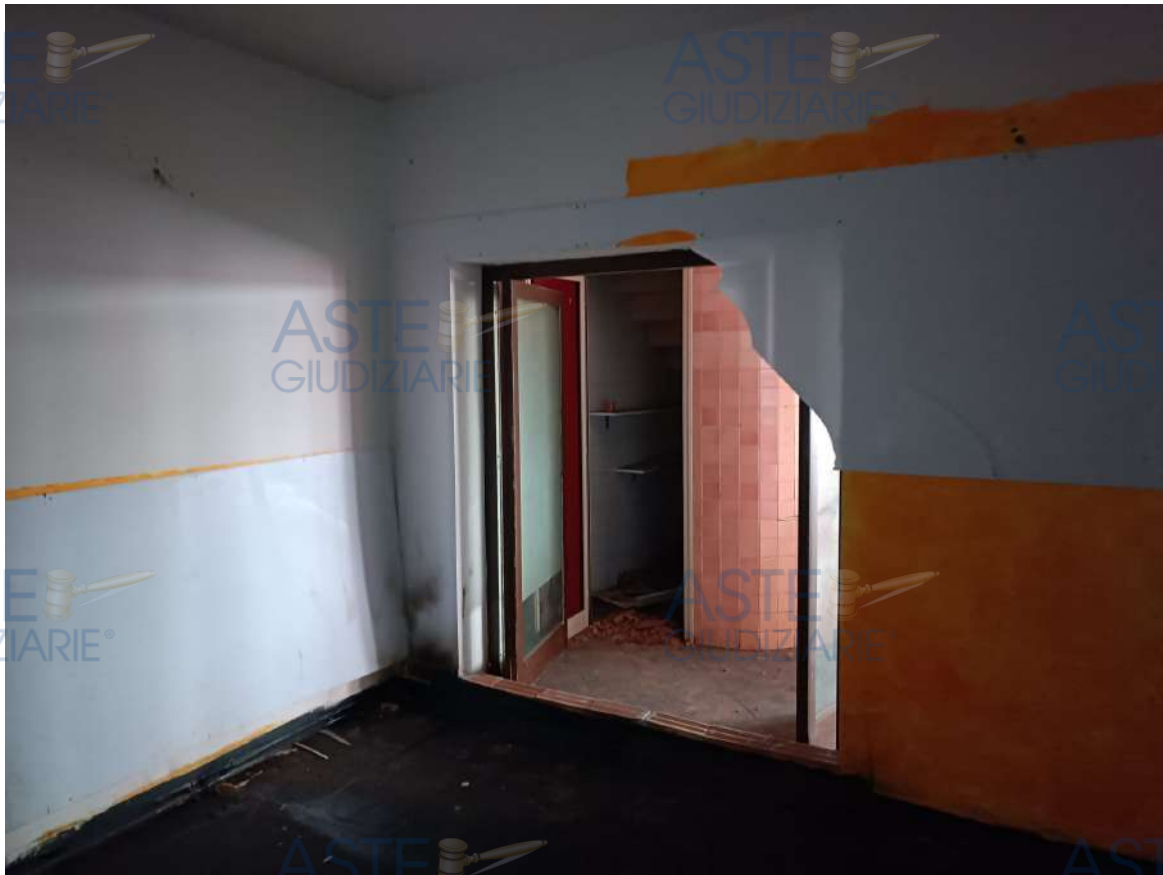
Foto 14: Particolare dell'accesso dalla sala ristorante 1 alla cucina
