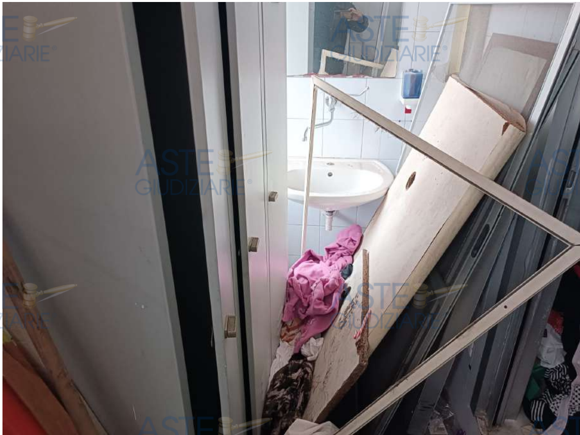
Foto 6: Particolare del bagno
