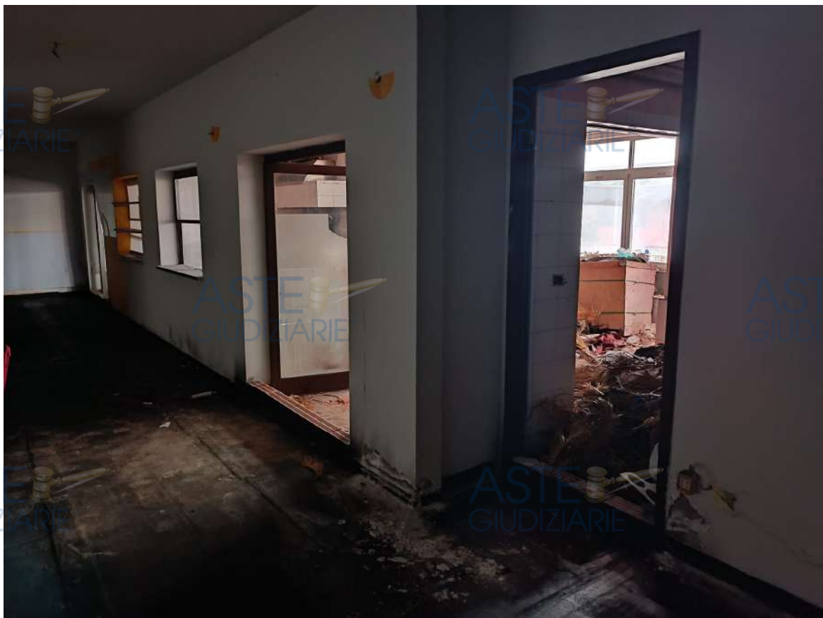
Foto 13: Particolare degli accessi dalla sala ristorante 1 alla cucina e all'antibagno
