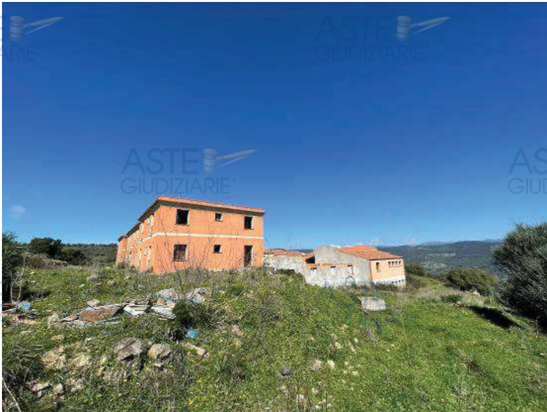
Vista del fabbricato dal terreno circostante – prospetto est
