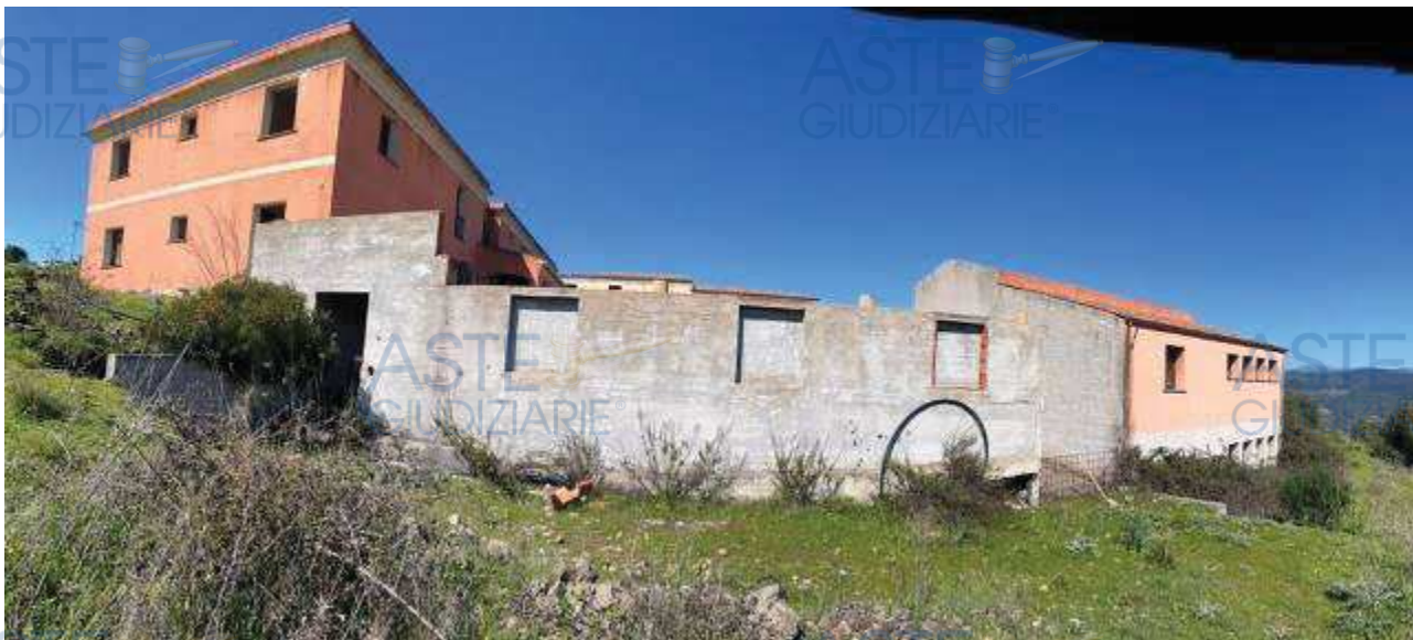
Prospetto lato destro del fabbricato
