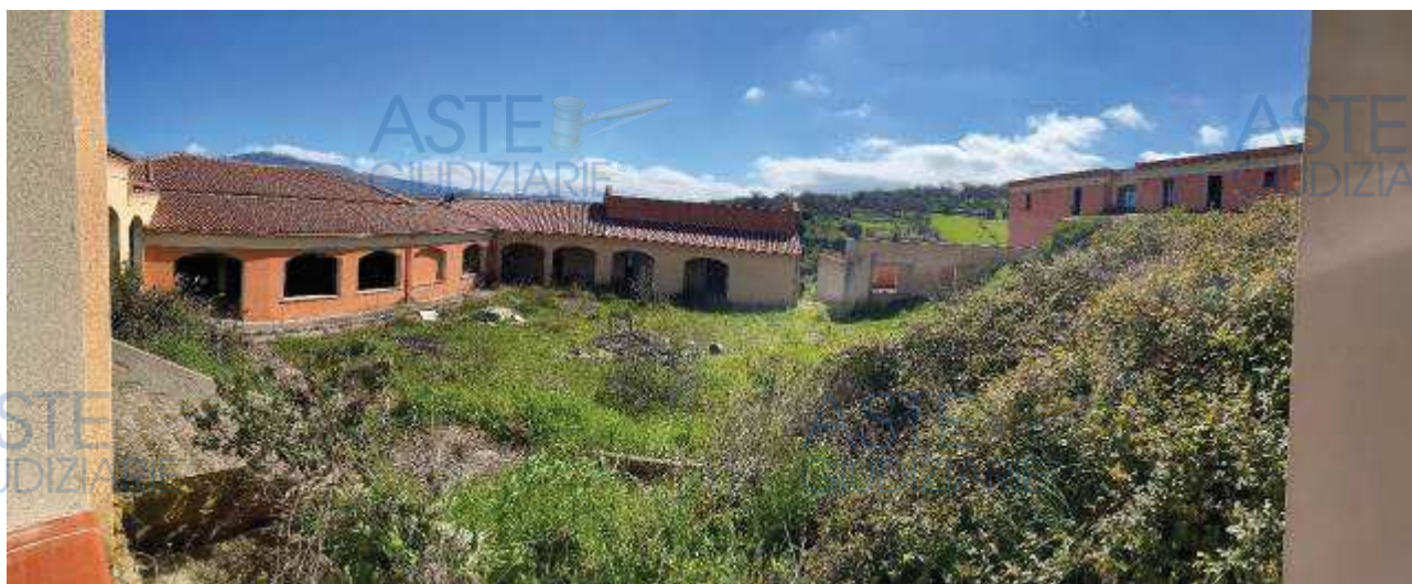
Vista dal lato sinistro verso l'interno della struttura
