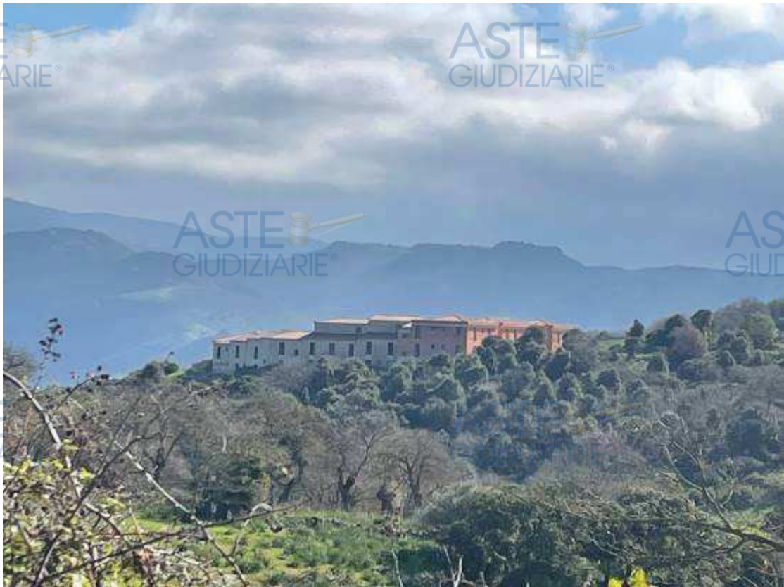
Vista della struttura dall'ingresso dalla strada pubblica
