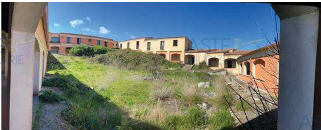
Vista dalla loggia destra verso l'interno
