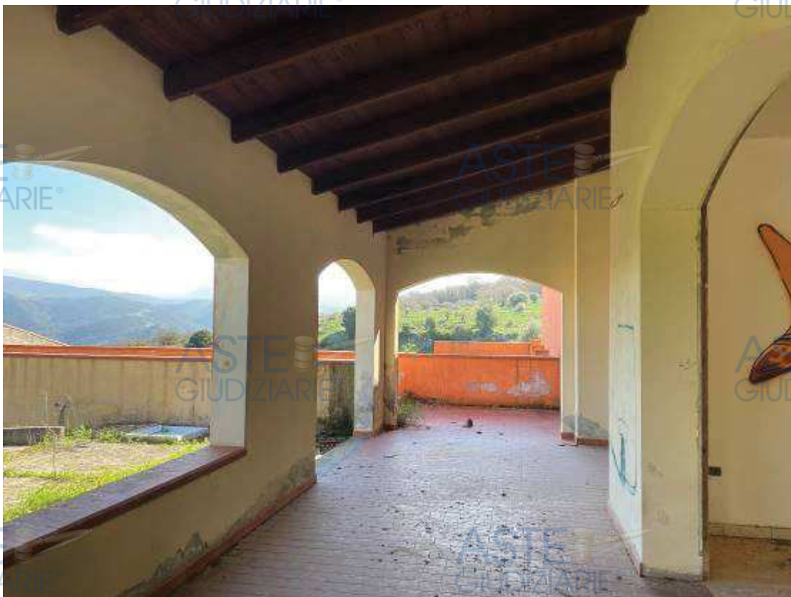
Vista del porticato antistante la hall della struttura
