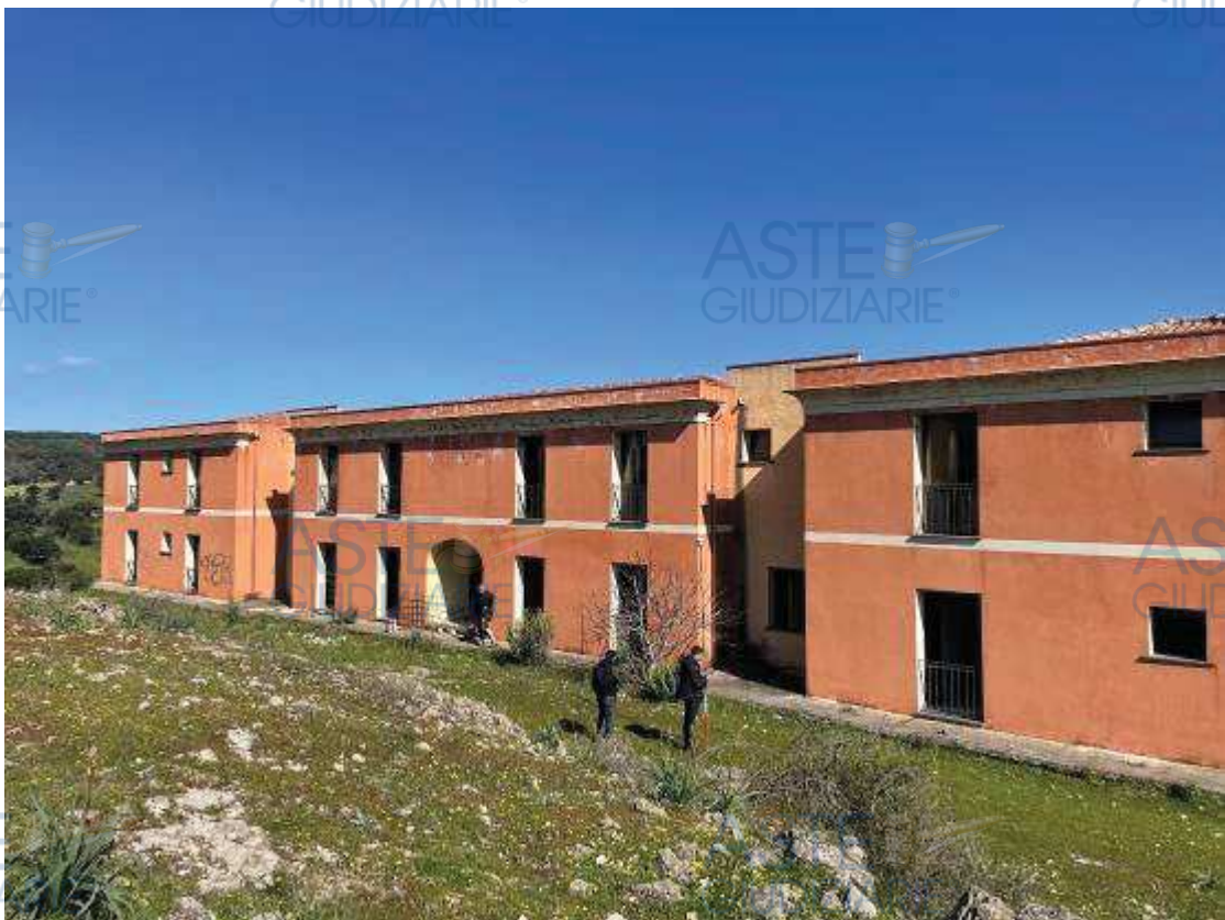
Prospetto sud – lato ingresso
