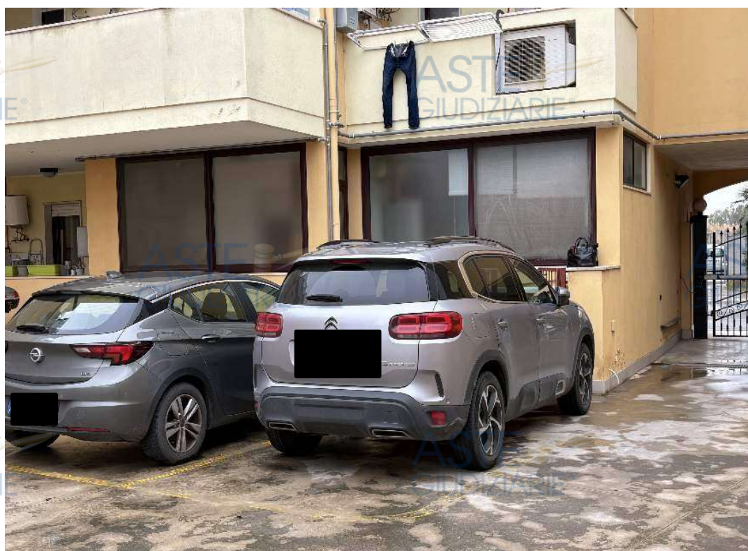
Foto n.24. Via Filippo Turati n.87- Quartu Sant'Elena. Cortile di proprietà esclusiva con cancelletto pedonale di accesso al cortile condominiale.
