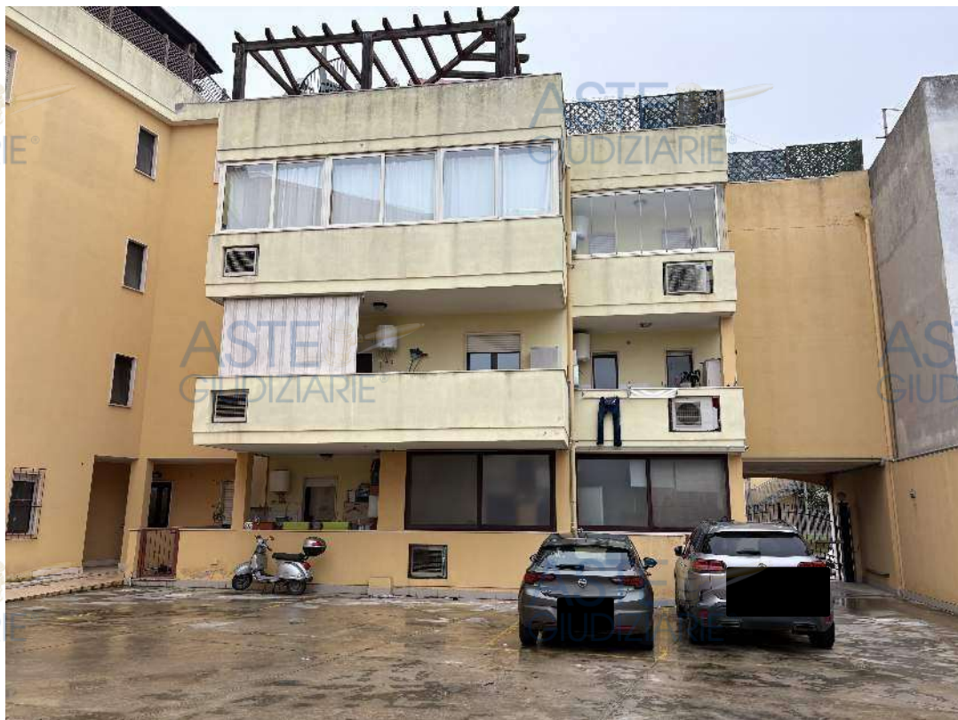
Foto n.28. Via Filippo Turati n.87- Quartu Sant'Elena. Prospetti lato cortile interno.
