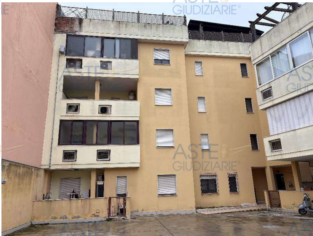
Foto n.27. Via Filippo Turati n.87- Quartu Sant'Elena. Prospetti lato cortile interno.
