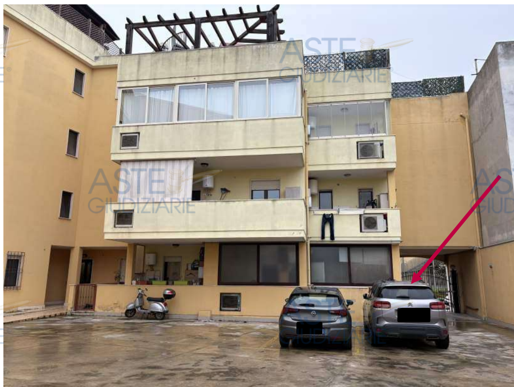
Foto n.5. Via Filippo Turati n.87- Quartu Sant'Elena. Cortile con parcheggi scoperti. La freccia indica il parcheggio di pertinenza dell'immobile pignorato.
