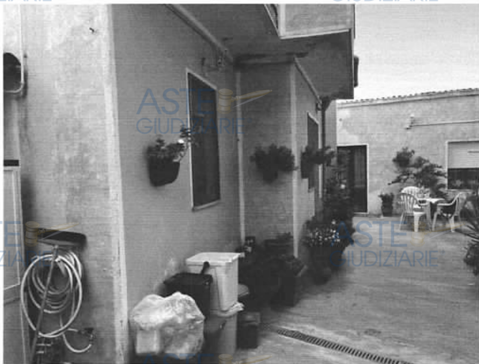
Foto 01: Prospetto lato Cortile interno (26/09/2023)
