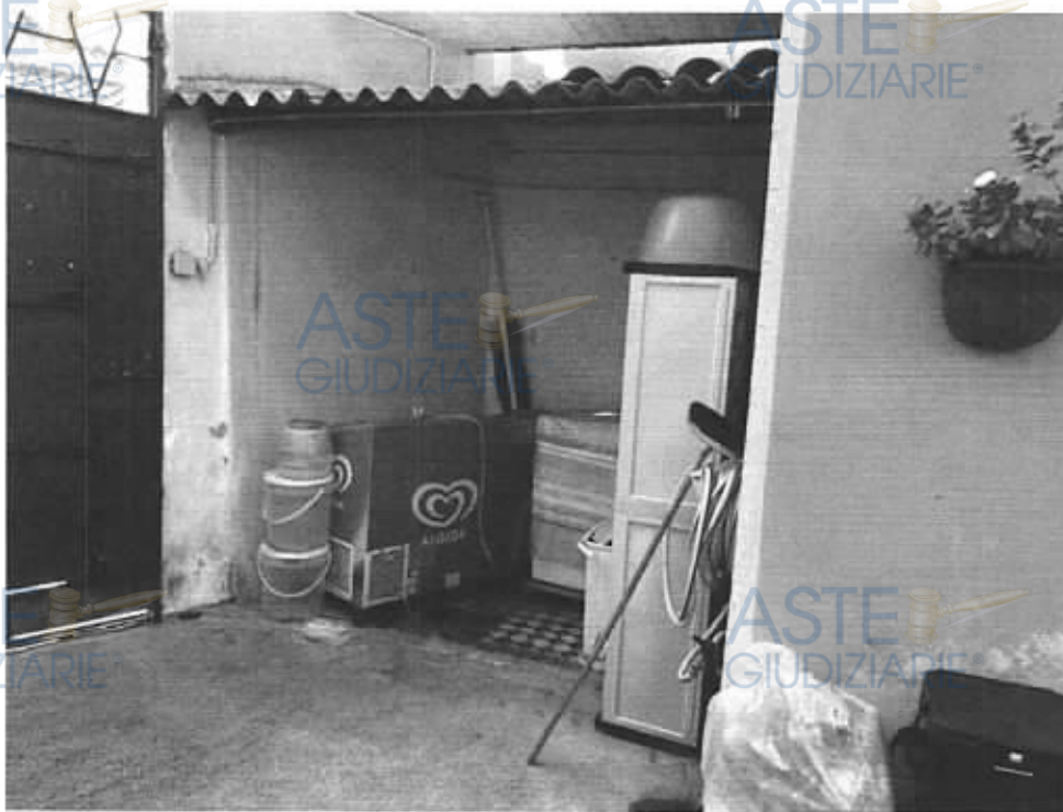
Foto 7: Tettoia abusiva da rimuovere su cortile (26/09/2023)
