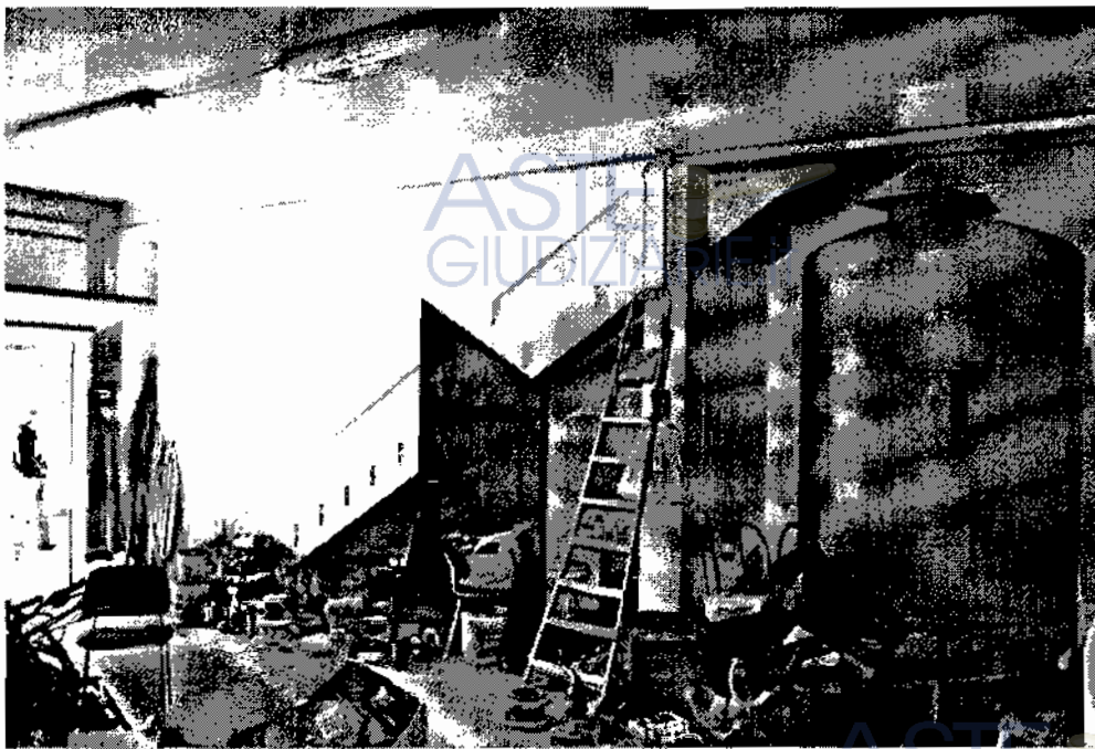
Garage via Indipendenza – Vista 03
