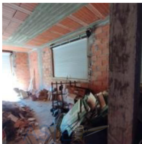
Vista su vano infisso – via delle Camelie
