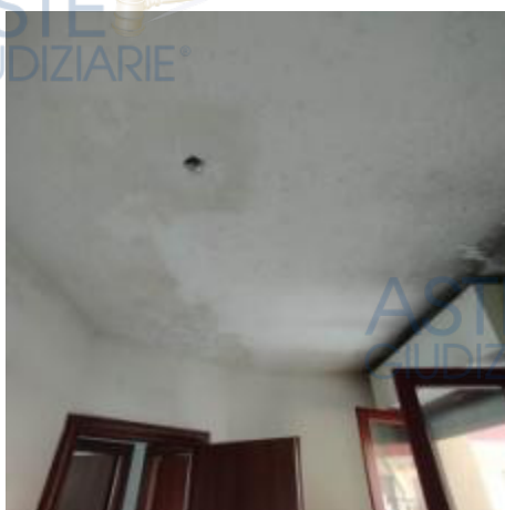
Soffitto – condizioni attuali
