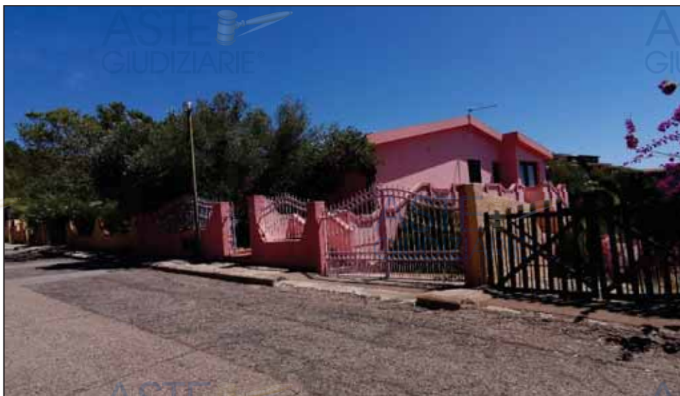
Foto del fabbricato.
