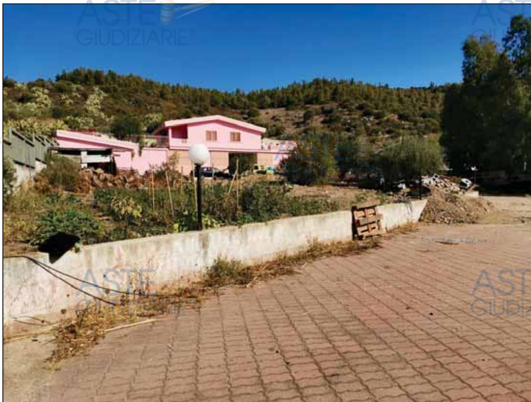
Foto del fabbricato.
