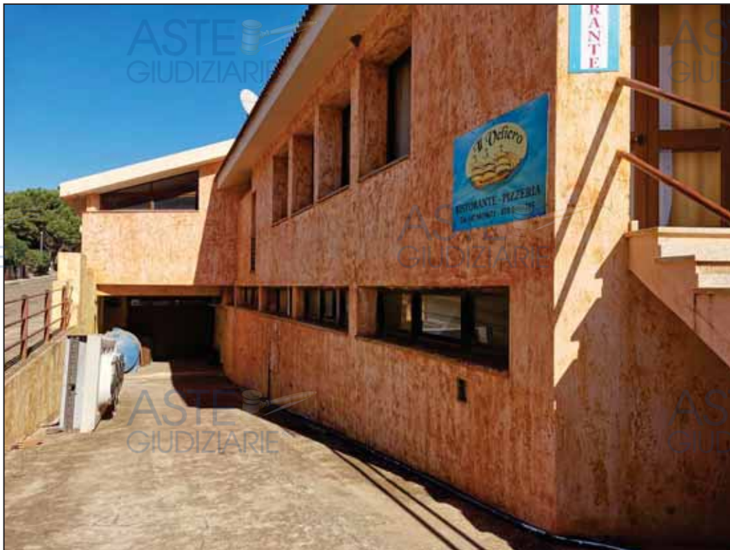
Foto del fabbricato.
