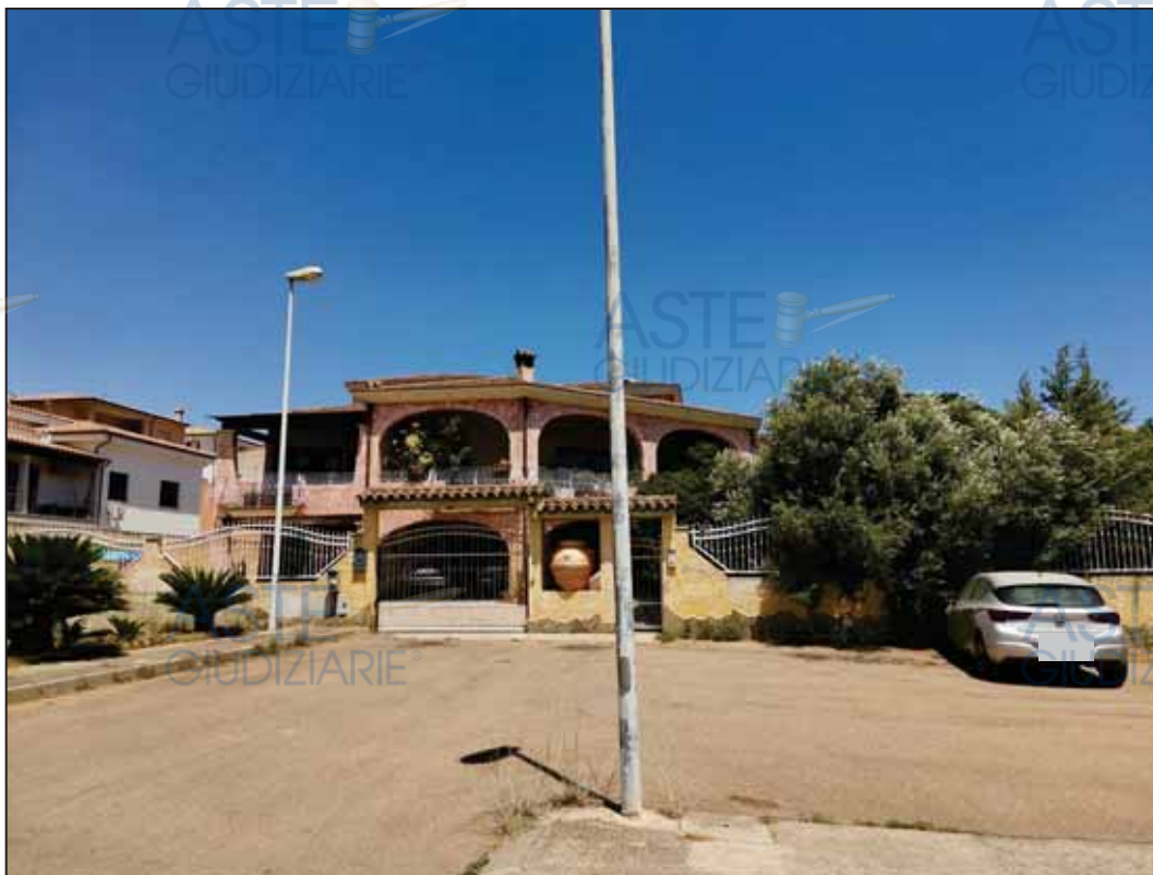
Foto del fabbricato.
