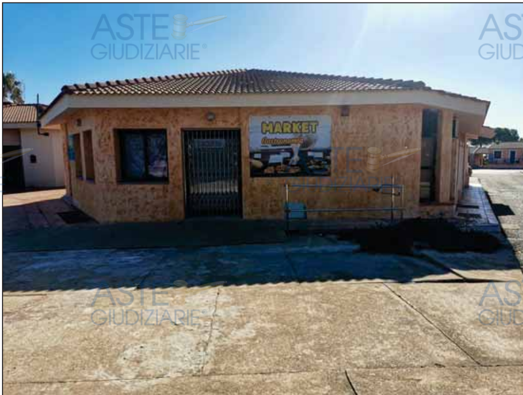
Foto del fabbricato.
