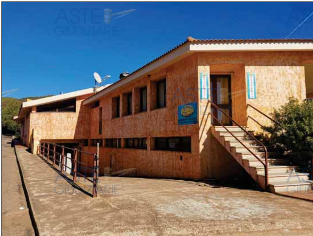
Foto del fabbricato.
