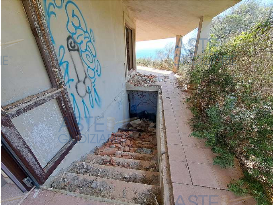
Scala accesso allo scantinato
