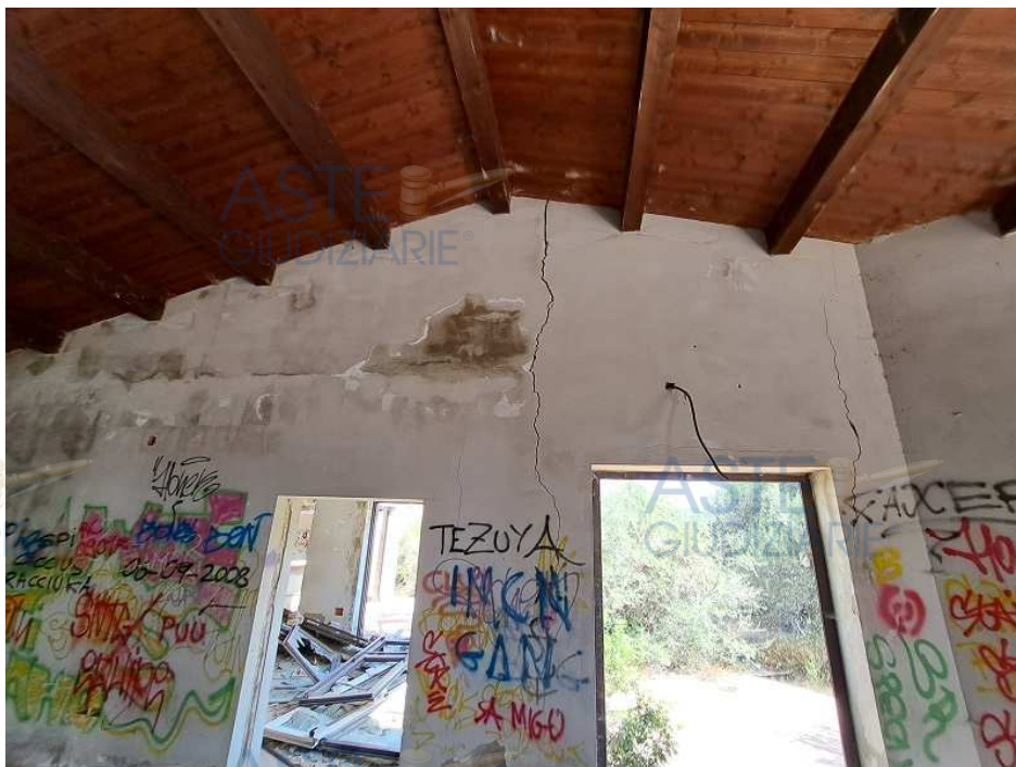
Muratura sala ristorante
