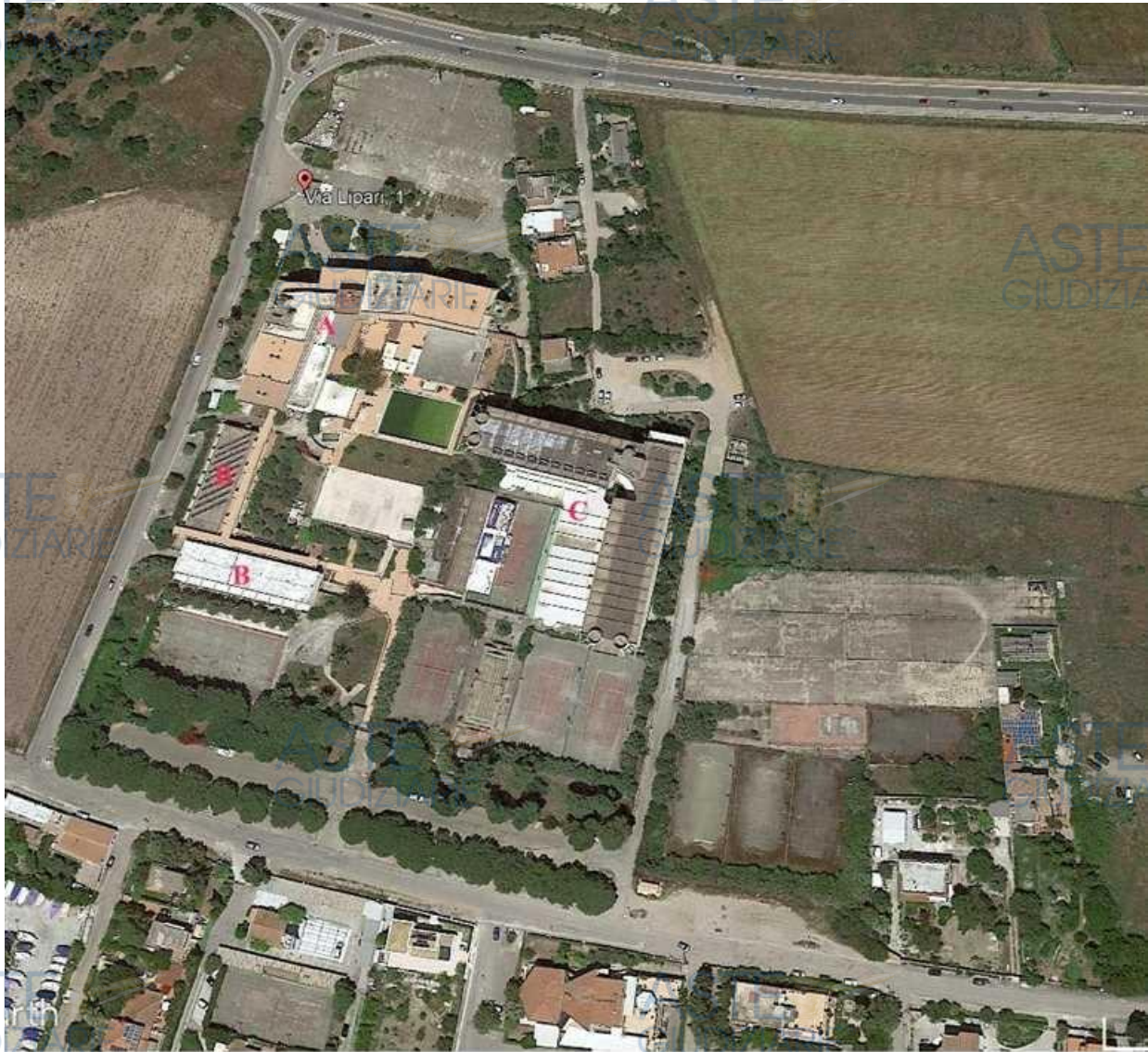
FOTO AEREA DEL COMPLESSO ALBERGHIERO
