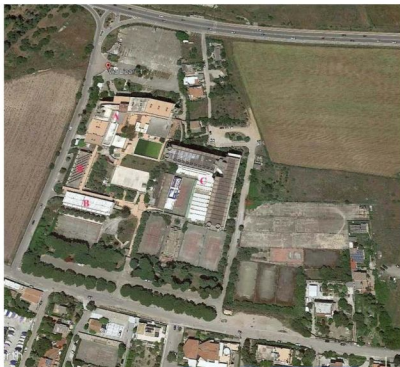
FOTO AEREA DEL COMPLESSO ALBERGHIERO
