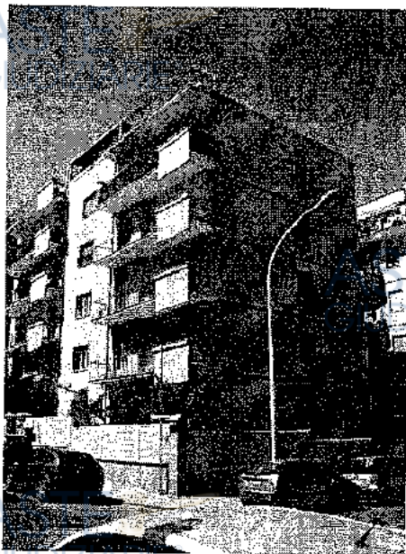
FOTO 1 – Il fabbricato di via Solmi all'angolo con via Gazano
