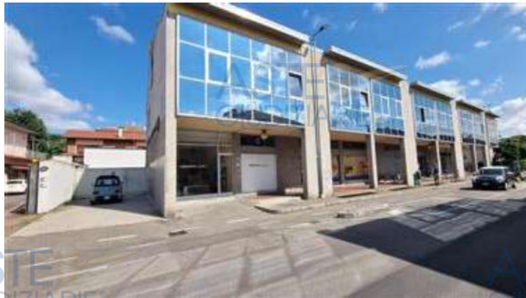
facciata principale edificio
