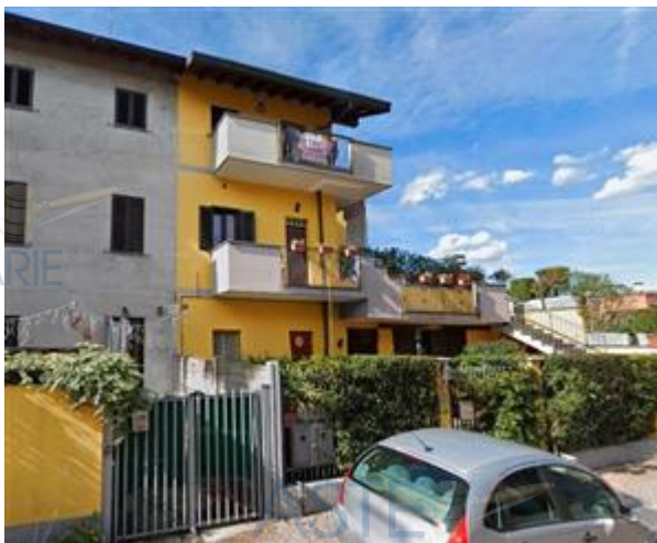
Facciata edificio da strada pubblica Via Tevere 7
