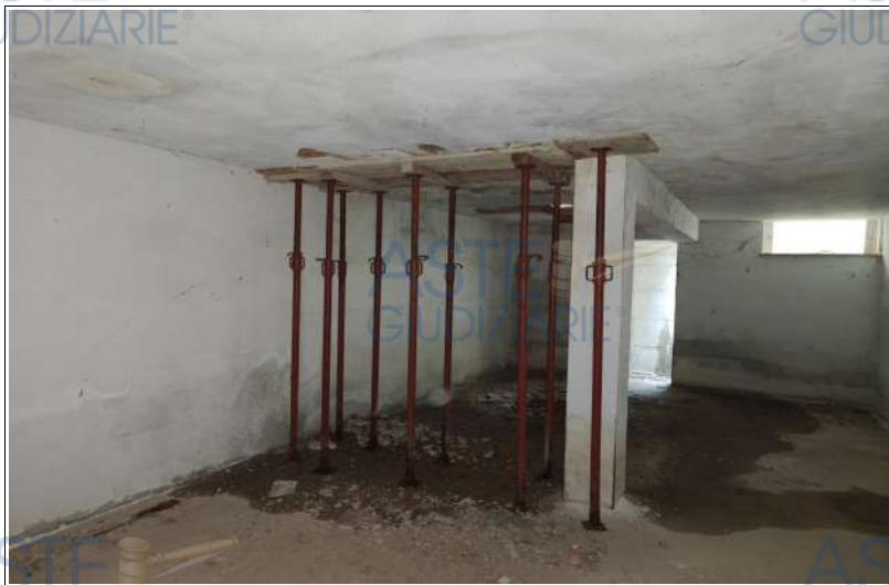
Il locale sgombero con il puntellamento dove si è danneggiato il solaio
