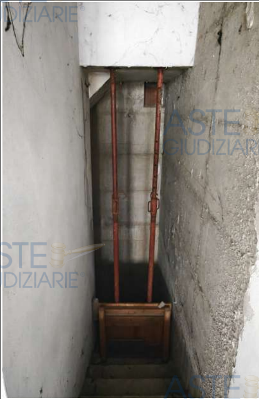
La scala di comunicazione tra box auto e locale sgombero con i puntelli
