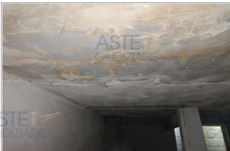
Tracce di infiltrazioni dal solaio del locale sgobero
