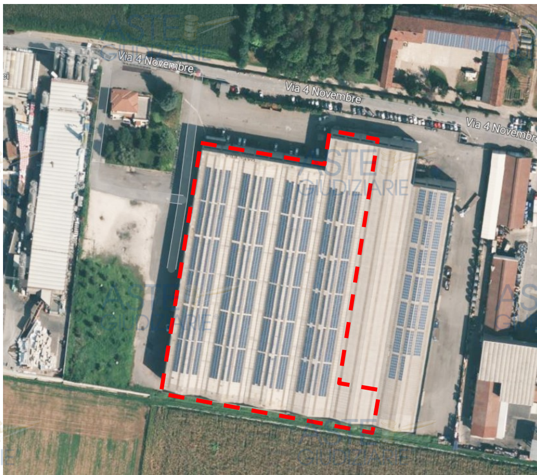
Figura 01: Copertura capannone: individuazione sommaria perimetro sub. 13
