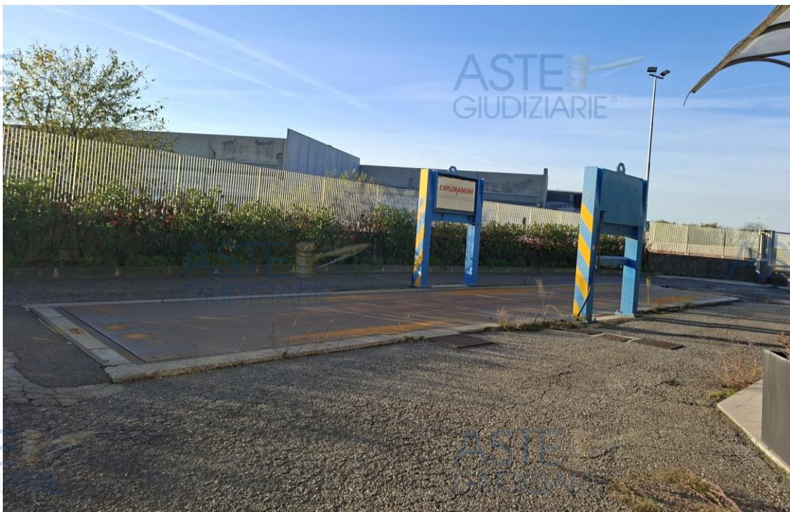
Figura 5: pesa e portale radiometrico
