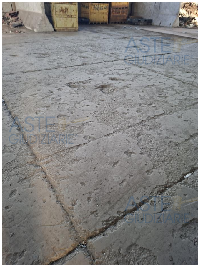
Figura 8: pavimentazione interna al capannone
