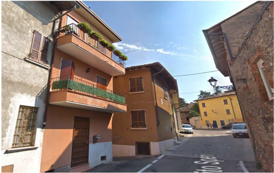
ESTERNA DELL'IMMOBILE (Fonte Google Maps) - 2021
