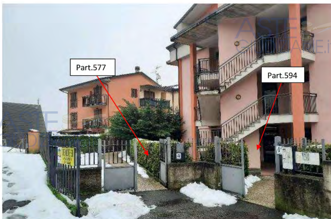
Accesso pedonale al "Fabb.to C" n.4 e al "Fabb.to B" n.4A, oggetto del presente provvedimento
