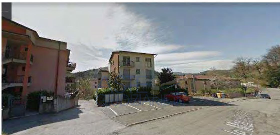
Vista da Nord da Viale Maria Luigia n.4
