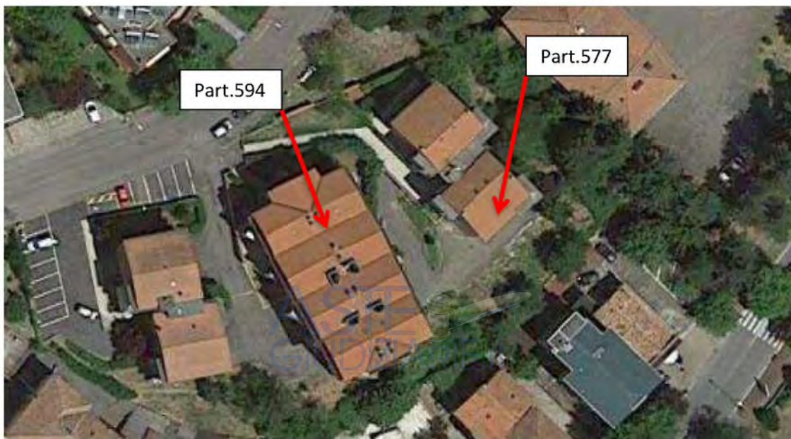
Vista in dettagli del complesso immobiliare con i due condomini
