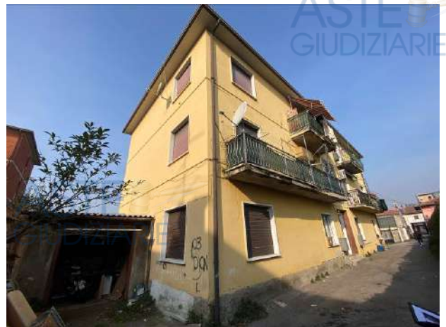
Fig. 06: Angolo sud-est del fabbricato
