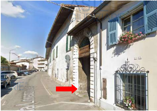
Fig. 03: Accesso carraio, via Gigli n. 17
