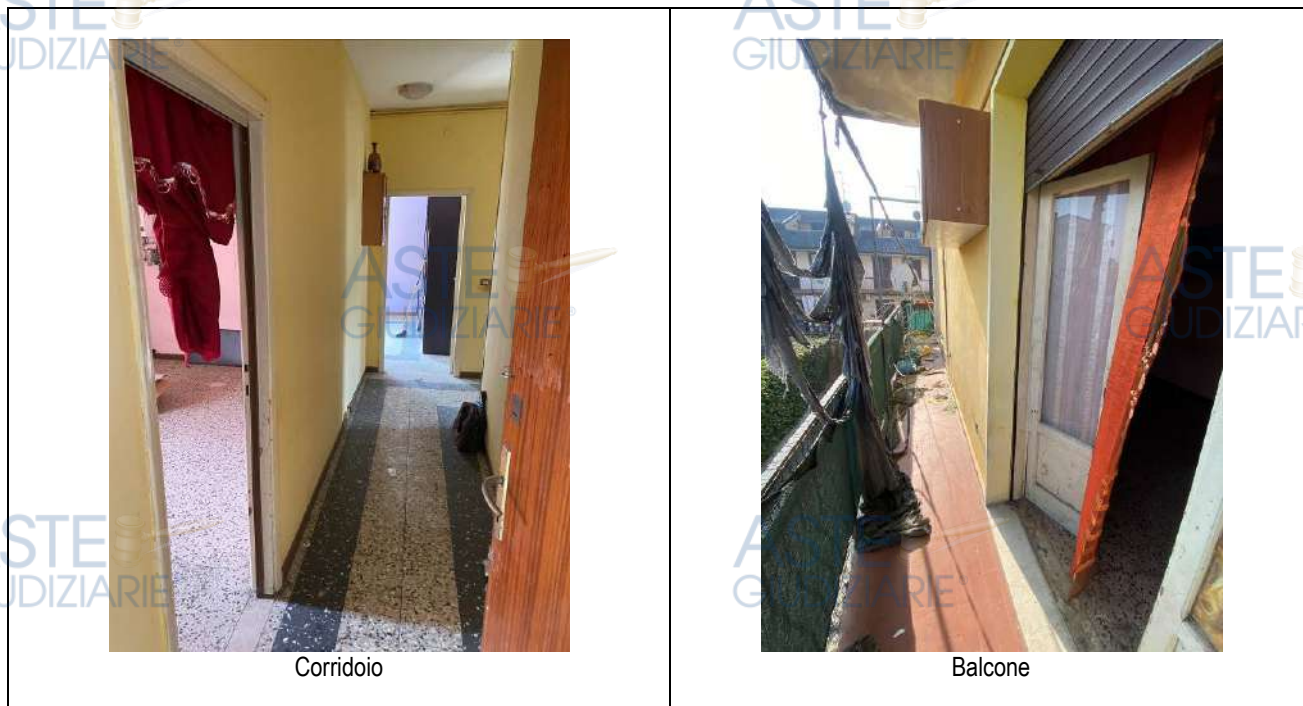
Fig. 14: Finiture abitazione piano primo sub. 3
