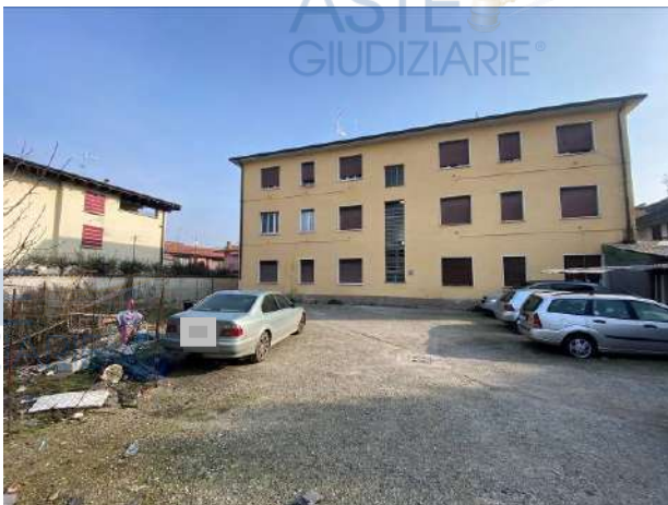
Fig. 07: Vista del fabbricato dal cortile comune
