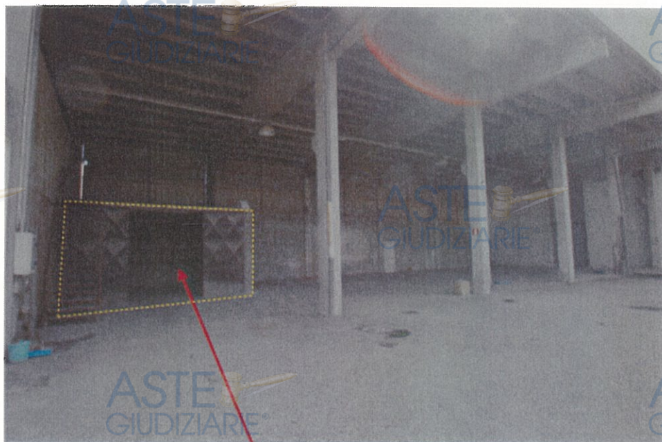
Ripostiglio non autorizzato.
