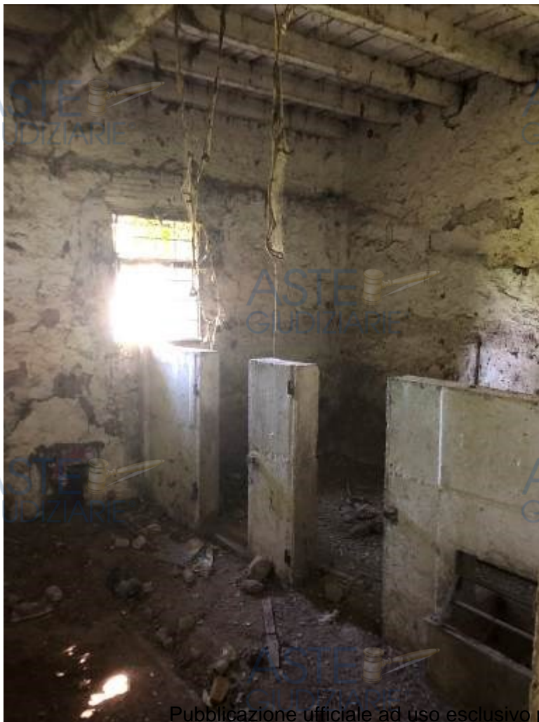
Foto n. 18 - Interni zona locali accessori
