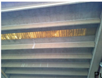
FOTO 21 CAPANNONE/TETTOIA (particolare tetto con evidenti segni di infiltrazioni)
