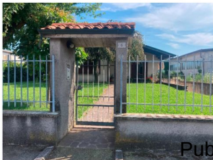
Fotografia della porta realizzata in difformità rispetto a quanto autorizzato
