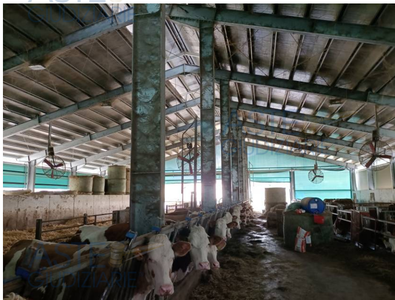
INTERNO DELLA STALLA
