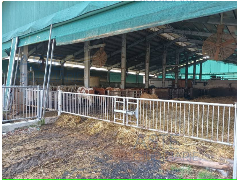
PARTE POSTERIORE DEL FABBRICATO
