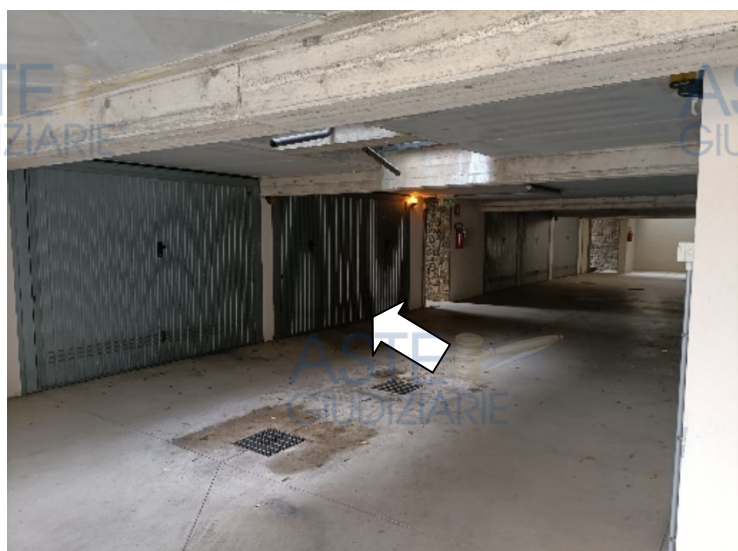
AUTORIMESSA FOTOGRAFIA N.11 E 12
