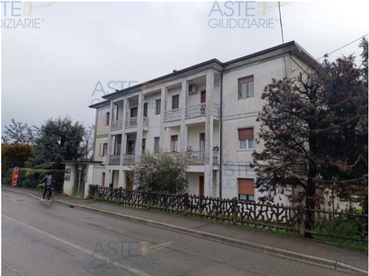
Foto 1: Prospetto Est fabbricato
