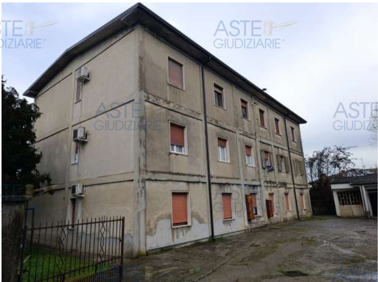
Foto 2: Prospetto Ovest fabbricato
