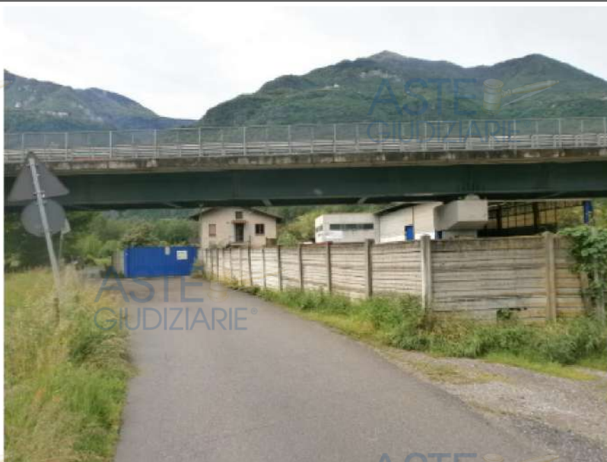
N. 21 - Vista ingresso da via Fermi, con la soprastante superstrada 42 della Val Camonica.
