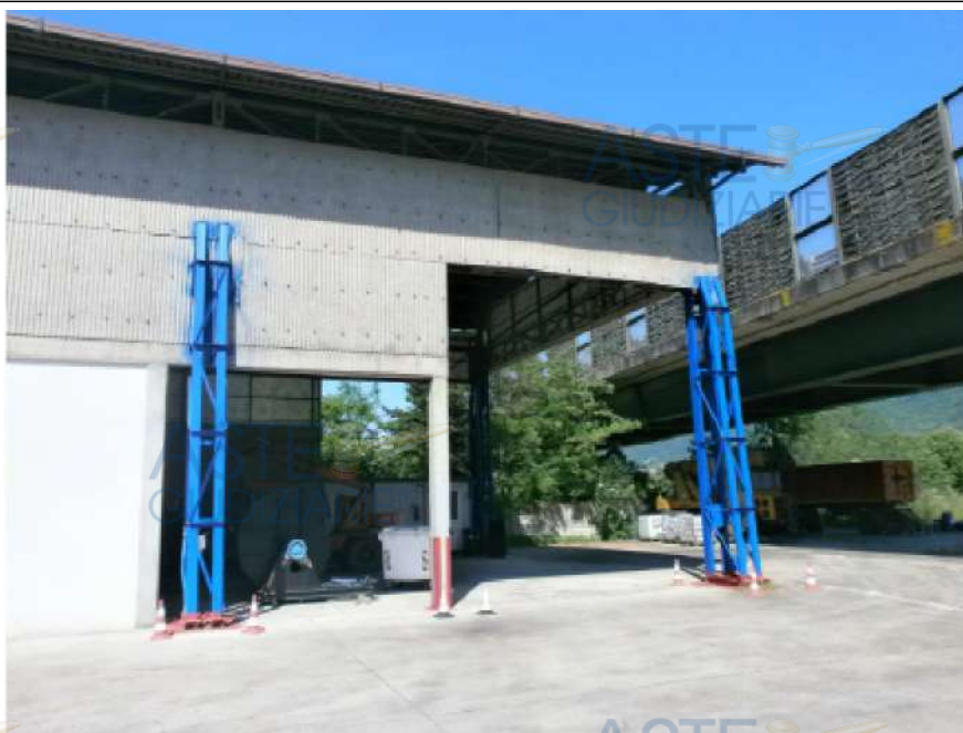
N. 5 - Dettaglio lato sud
