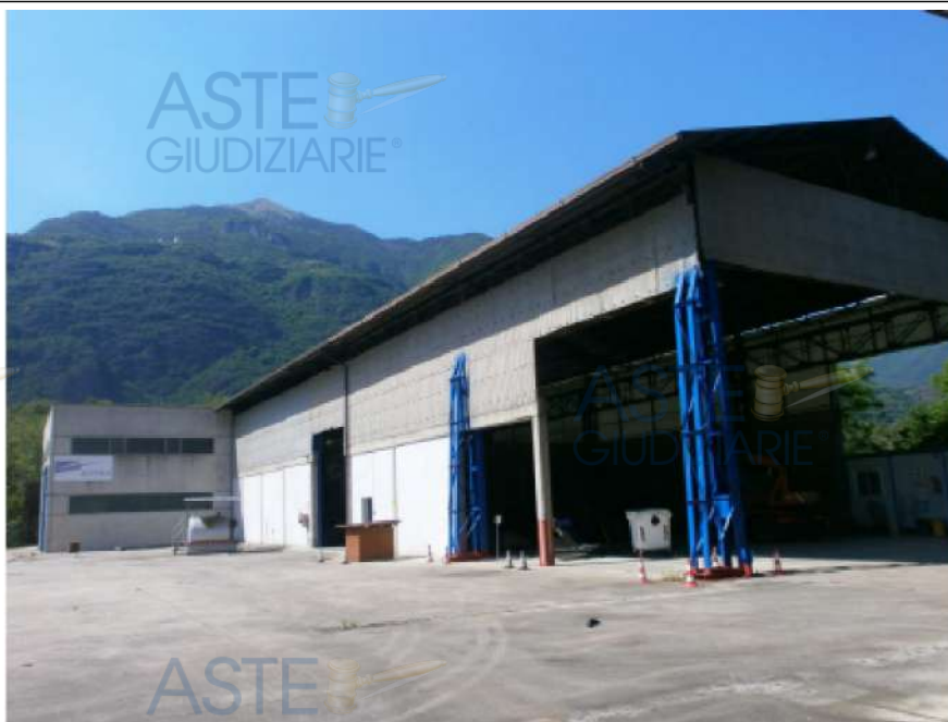
N. 4 - Vista generale, lato sud
