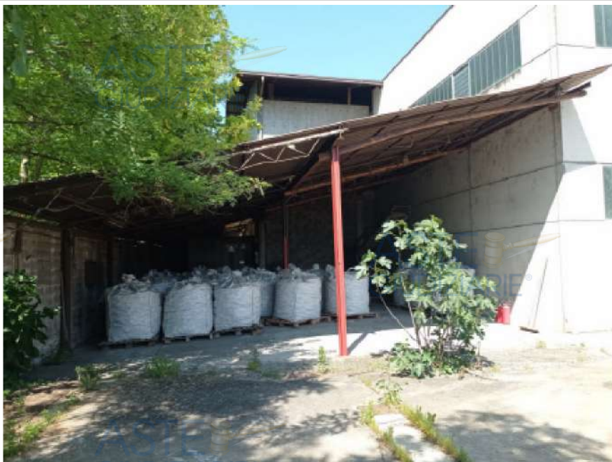
N. 12 - Vista portico sul lato sud
