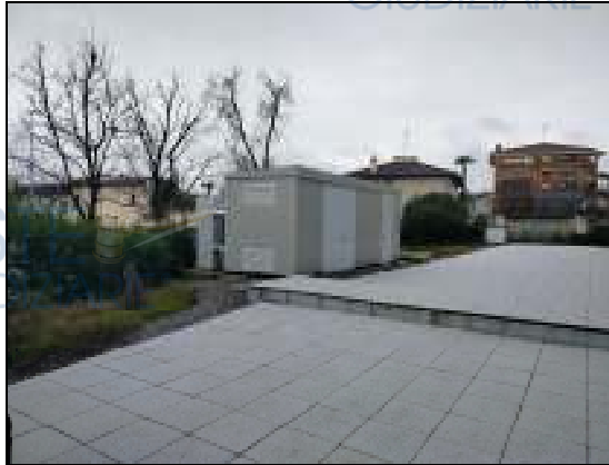
NUOVA CENTRALE TERMICA
