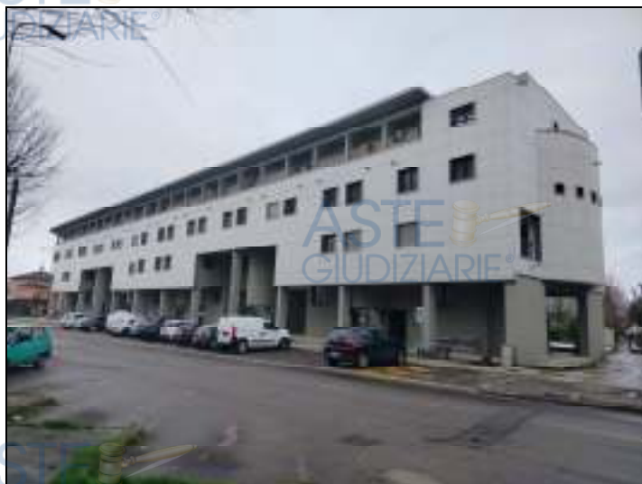
VEDUTA ESTERNA EDIFICIO
