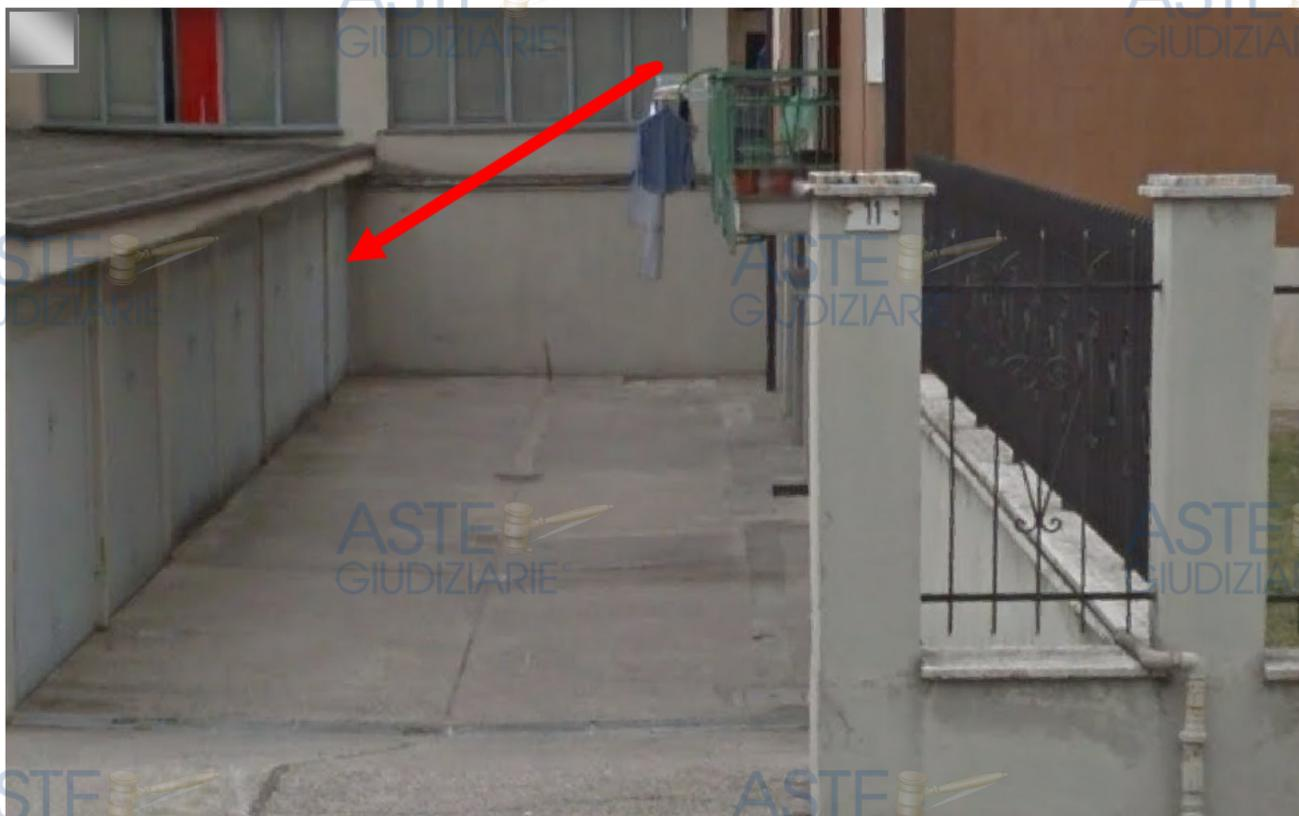
La costruzione è in c.a. con porta basculante in alluminio. L'estradosso della soletta di copertura è impermeabilizzato con manto bituminoso. L'altezza interna è 2,30 m.
