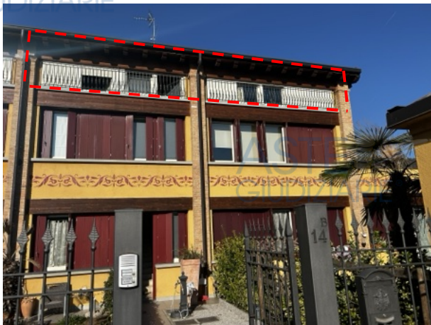
Fig. 3 – Veduta dell'edificio da Sud e affacci della u.i. oggetto della procedura esecutiva
