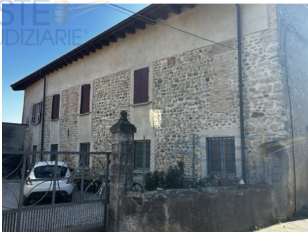
Fig. 5 – Vista della facciata retrostante dell'edificio da via Cominotti
