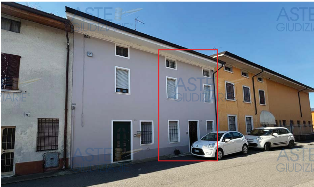
FOTO 1: vista del fabbricato dalla pubblica strada
