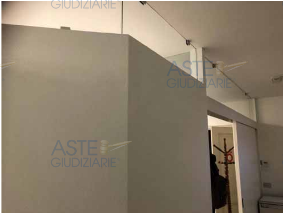
Vista delle tramezze interne in laterizio
