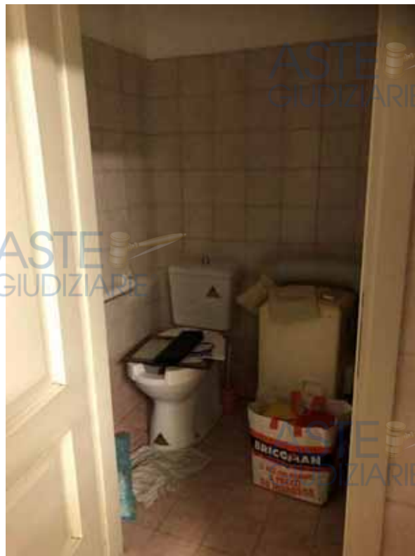
Vista del servizio igienico
