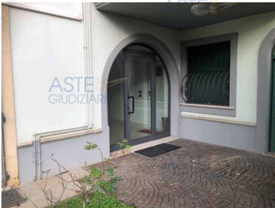
Ingresso vano scala comune
