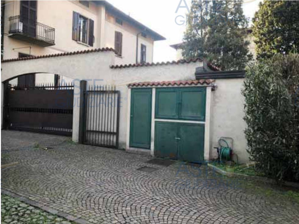
Vista del vano contatori
