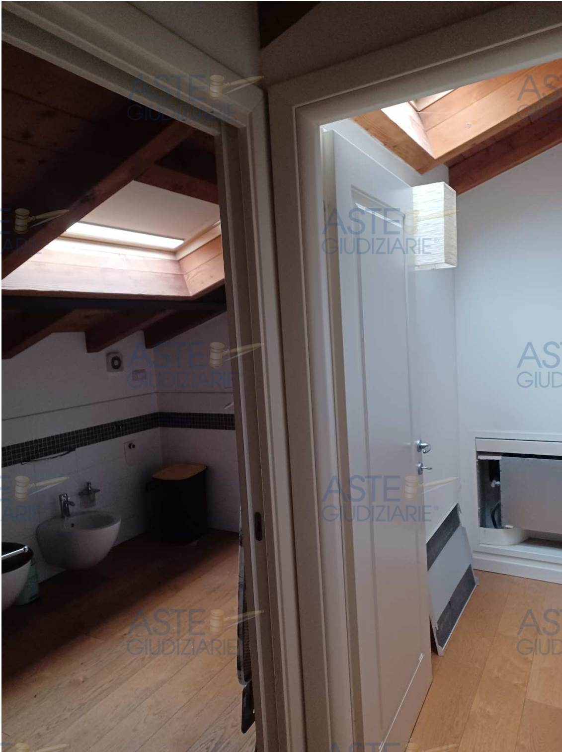
09 – Disimpegno verso il bagno
