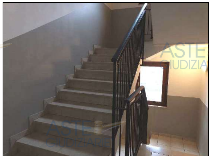
8 - rampa scala comune
