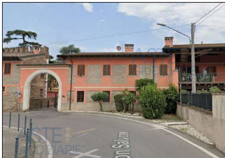
1 - ingresso complesso a civico 27 di via Battisti
