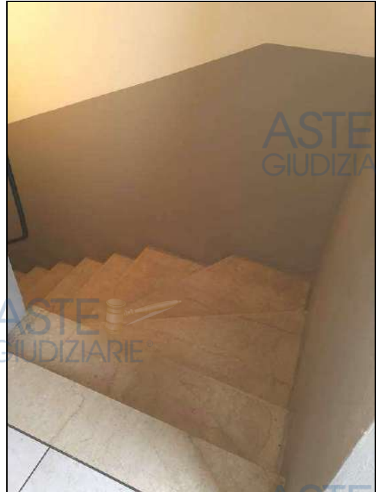
6 - rampa scale d'accesso all'interrato
