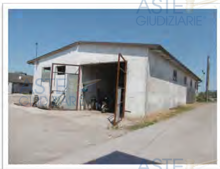
Particolare del fabbricato adibito a magazzini
