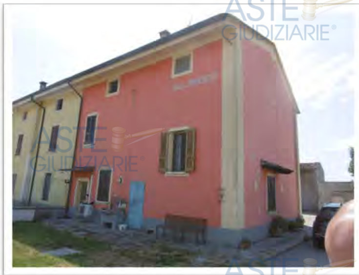
Particolare del fabbricato adibito ad alloggio del custode
