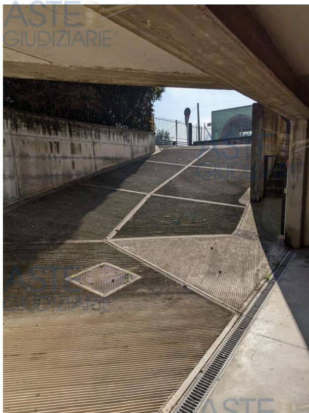
Fotografia n.14 rampa d'accesso carraio all'interrato
