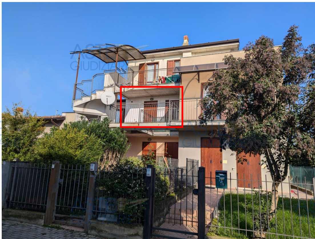
Vista da strada pubblica dell'immobile
