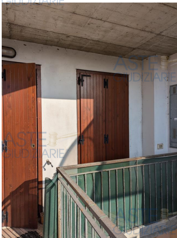
Vista Ingresso pedonale immobile
