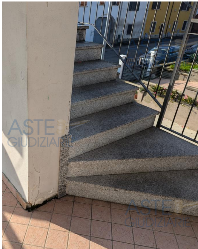
Vista scala condominiale esterna
