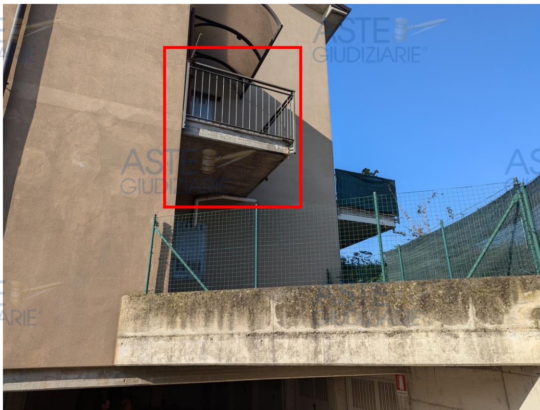
Vista balcone di proprietà lato nord
