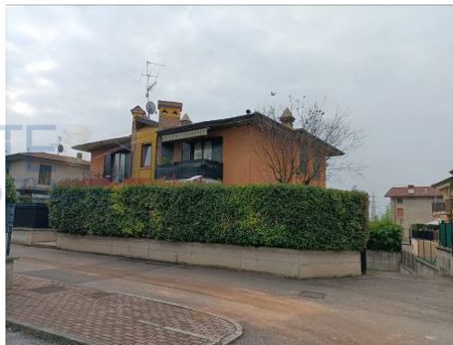
ESTERNO FABBRICATO (a destra l'accesso carroia a sinistra il pedonale)
