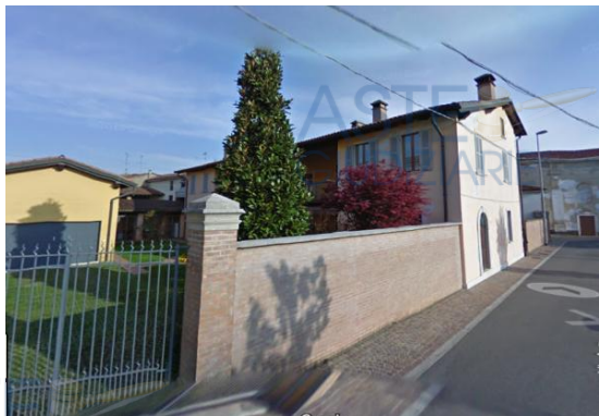
Foto 1 – ingresso su via San Faustino 43
