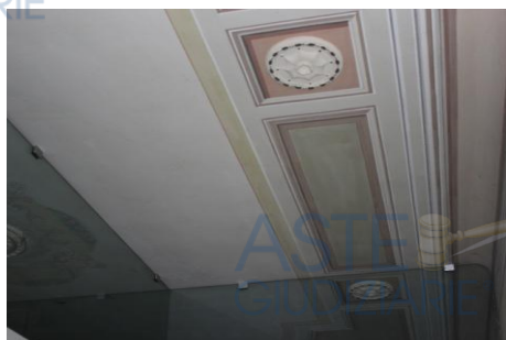
Foto 15 – soffitto camera sub. 9
