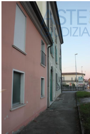
Foto 1 – Facciata laterale con ingresso su via Mazzini
