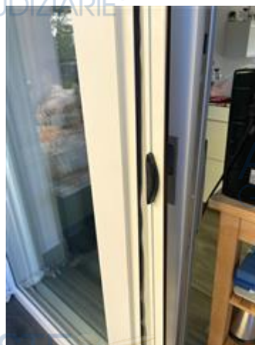
dettaglio porta finestra con zanzariera piano terra
