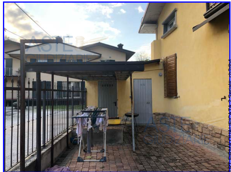
Foto n. 18 ripostiglio locale caldaia
