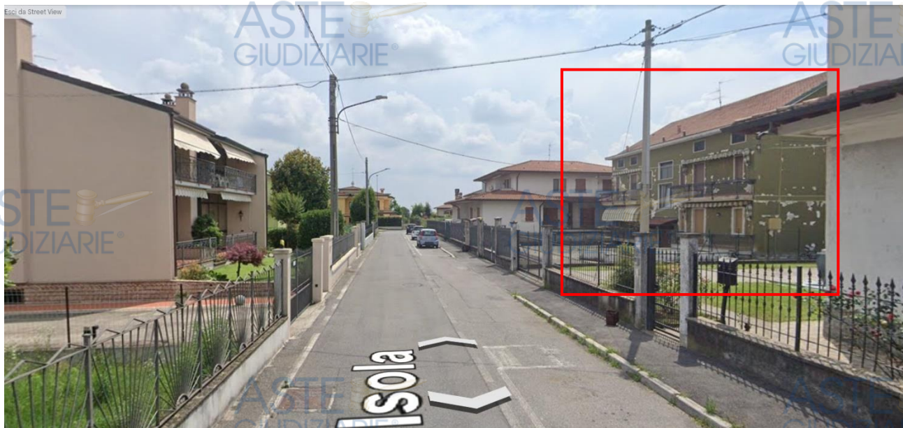
FOTO 1: vista del fabbricato dalla pubblica strada
