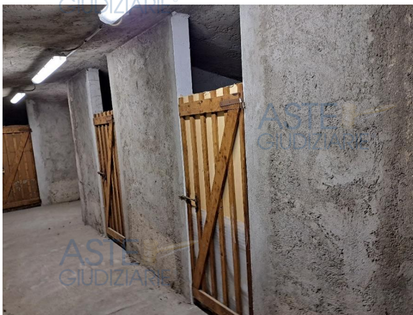
Vista corridoio e porta accesso al ripostiglio
