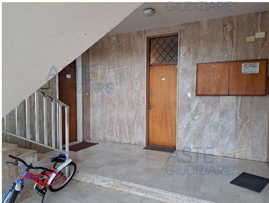
Vista atrio ingresso condominiale – piano terra
