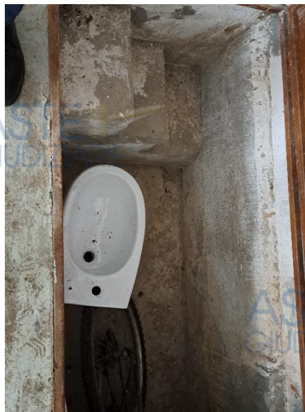
Ripostiglio sotto la quota del pavimento
