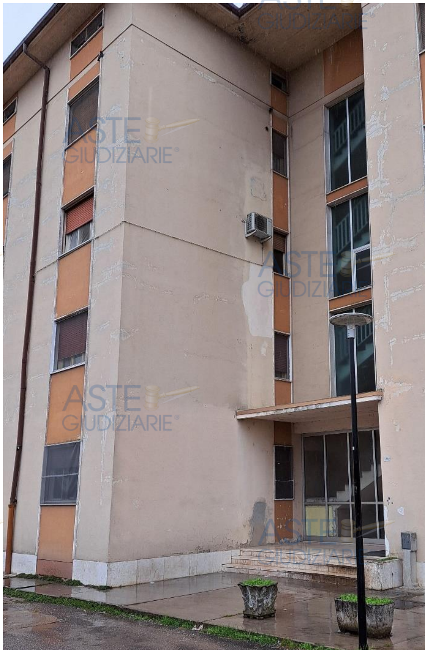
Facciata ovest – ingresso vano scala comune
