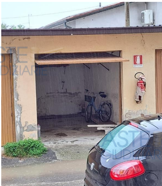
Vista esterna del garage a piano terra
