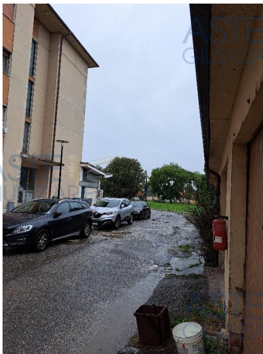
Strada di accesso all'autorimessa ed al condominio
