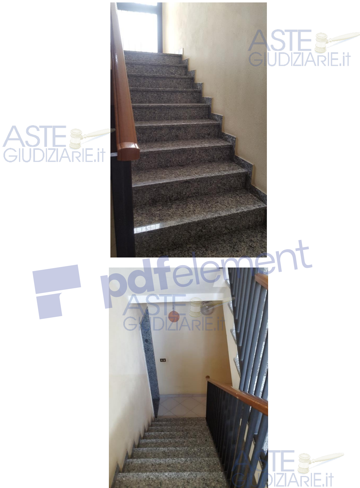
Scala con gradini e battiscopa in serizzo dal piano rialzato al piano primo.
