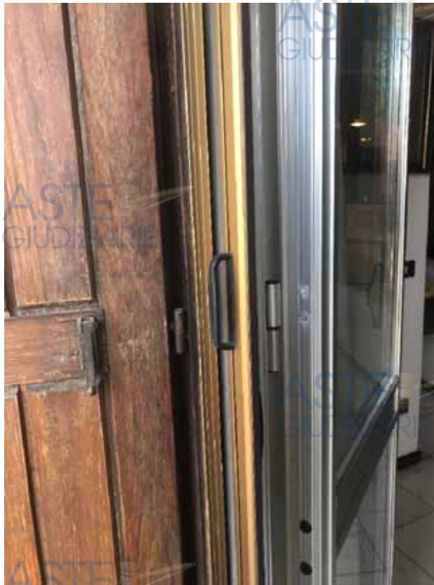
Dettaglio serramenti esterni
