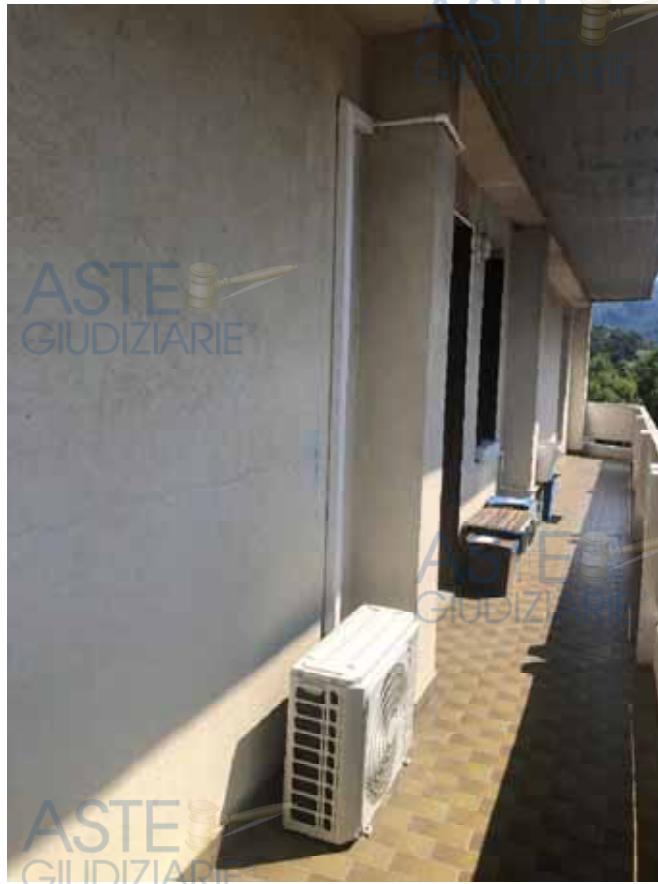
Balcone esterno lato cucina
