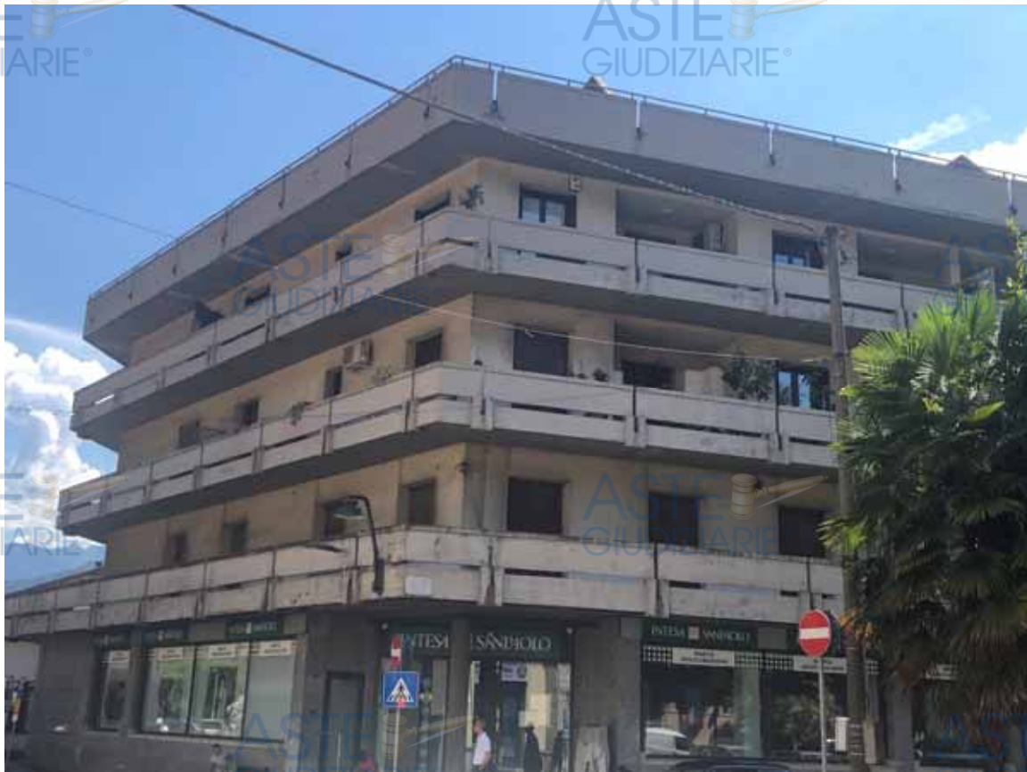
Vista edificio lato Ovest
