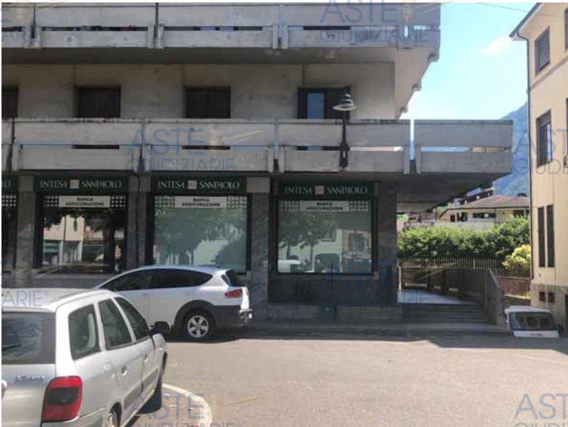
Vista edificio lato Sud
