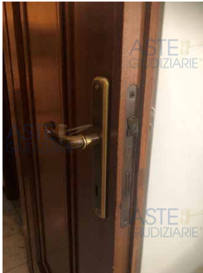
Dettaglio porte interne
