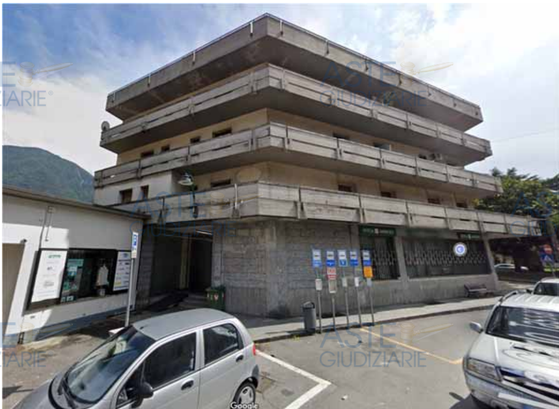
Vista edificio lato Nord
