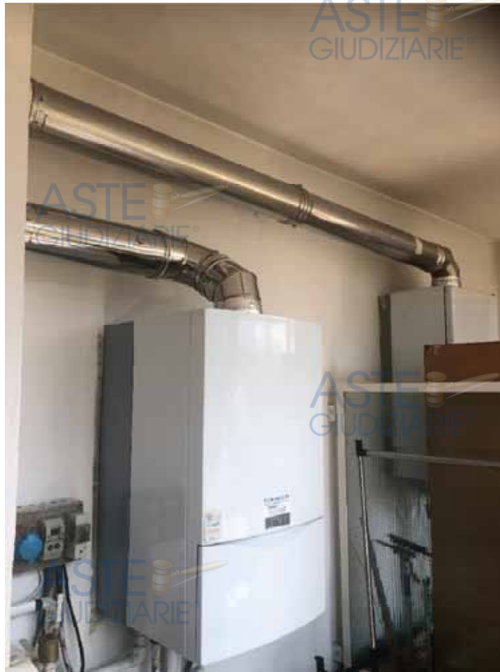
Dettaglio caldaia – si noti il tubo passante della proprietà confinante
