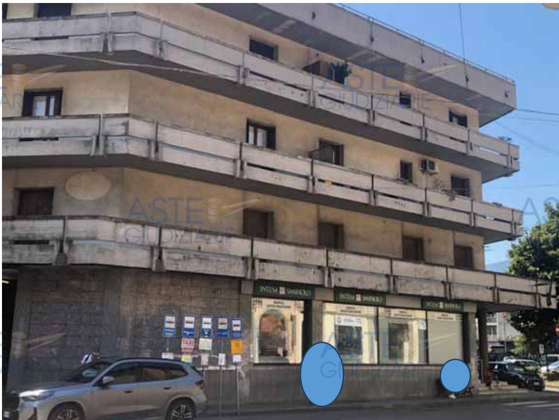
Vista edificio lato Sud-Ovest
