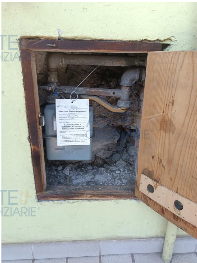
IL CONTATORE DEL GAS, ACCESSIBILE DA BALLATOIO ESTERNO, CON INDICAZIONE DELLA CHIUSURA DELL'UTENZA
