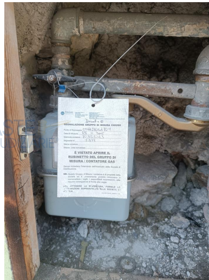
IL CONTATORE DEL GAS, ACCESSIBILE DA BALLATOIO ESTERNO, CON INDICAZIONE DELLA CHIUSURA DELL'UTENZA
