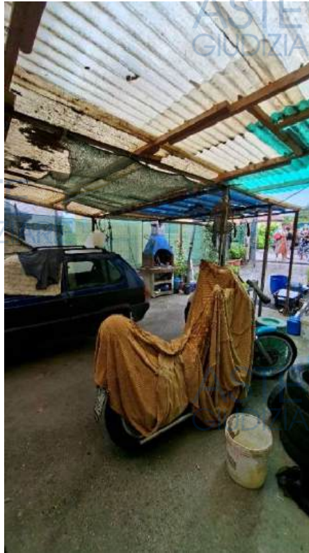
Foto n. 3 – tettoia in plexiglas
