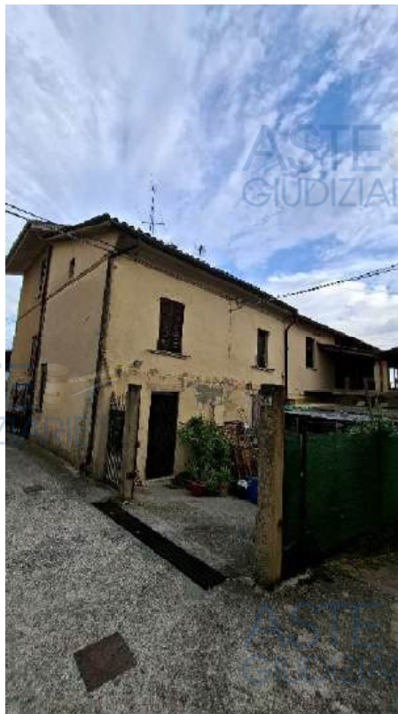
Foto n. 2 – prospetto da via Trento
