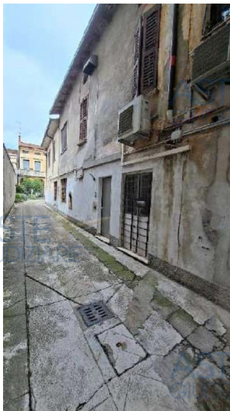
Foto n. 18 – passaggio comune lato verso via XX Settembre
