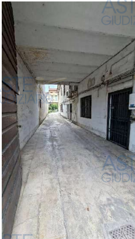
Foto n. 3 – androne di passaggio in comune
